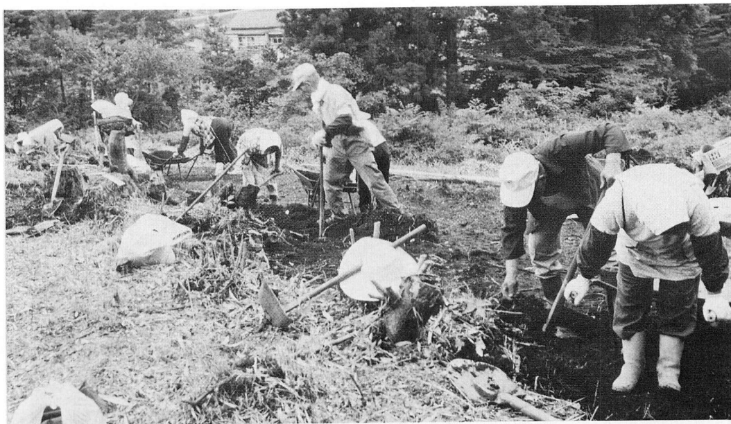
雑物撤去作業風景
