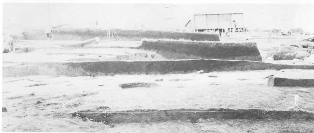
b. H III-12住居址群 (埋土の状況)
