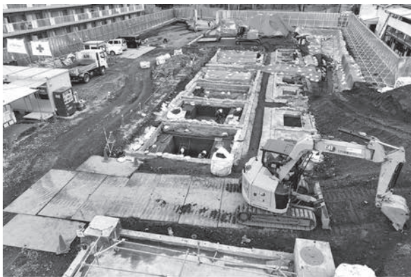
4 作業風景 (西から)
