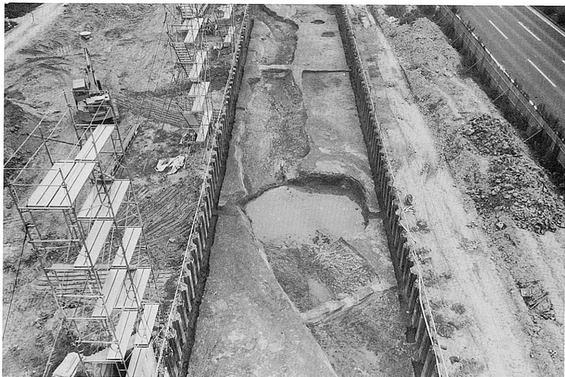
Bトレンチ 自然河川1 (北から)
