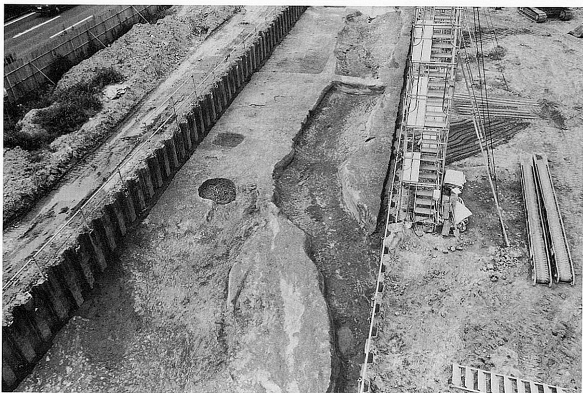
Bトレンチ 自然河川1 (南から)
