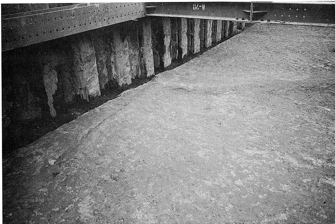
Bトレンチ 水田、畦畔（北西から）
