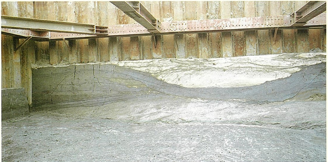
4 B トレンチ東セクション 弥生時代中期Ⅰ～縄文時代晩期（南西から）
