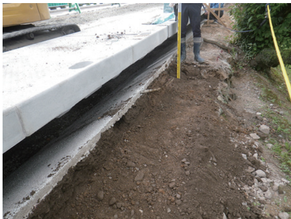
解説板再設置掘削（南から）
