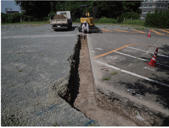
b 地点掘削状況
