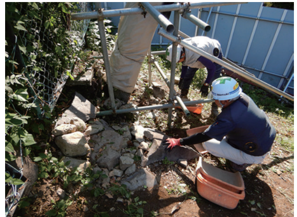
掘削作業 (西から)
