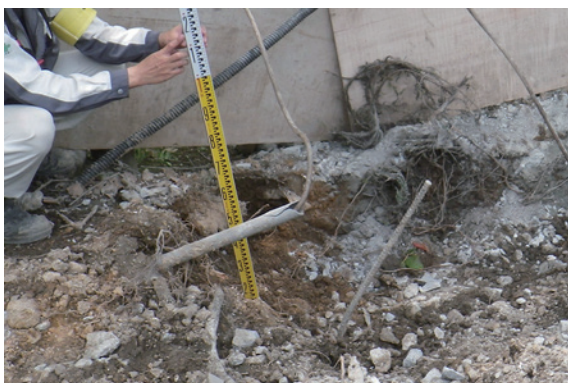
道路標識撤去（西から）
