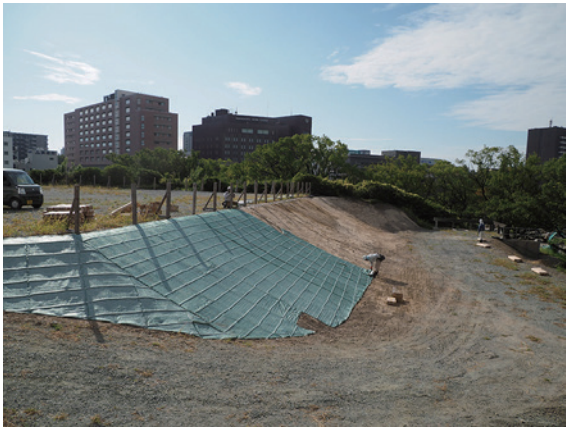
e 地点施工状況
