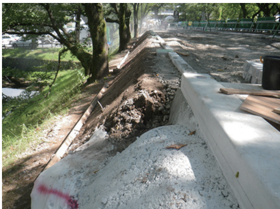
法肩工事盛土造成終了（北から）
