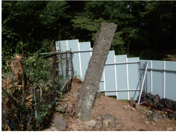
控柱養生作業前 (西から)
