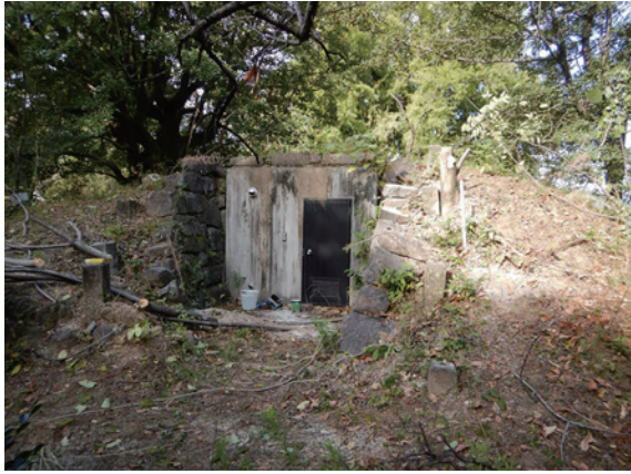
撤去前現況（東から）
