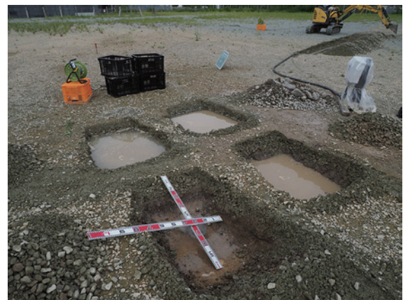
a 地点掘削状況
