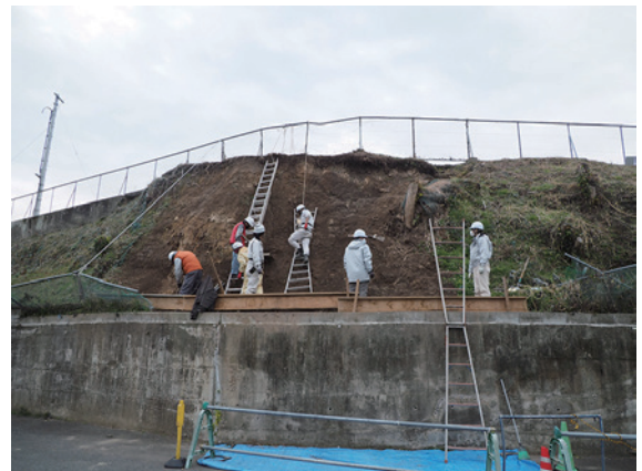
h 地点補修状況
