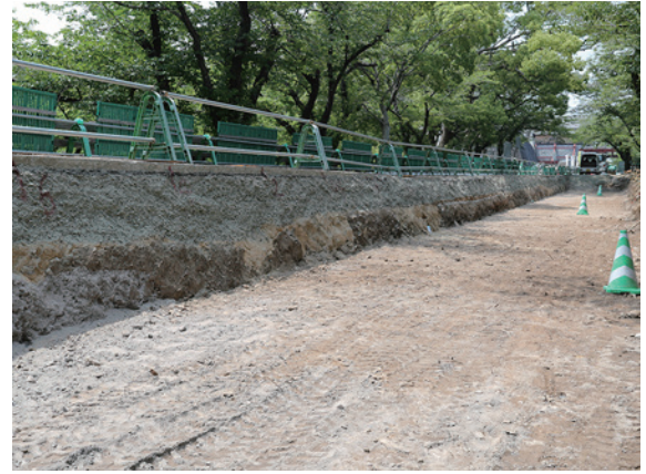
張り出し歩道部分掘削状況（南から）
