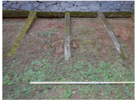
調査前近景（北から）
