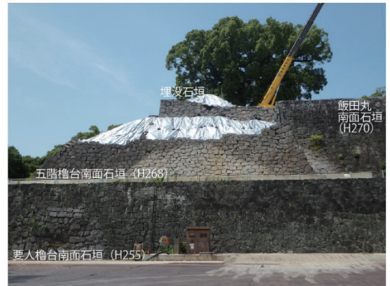
飯田丸五階櫓台・要人櫓台石垣（南より撮影）
