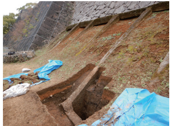
コンクリート基礎部検出状況（南西から）
