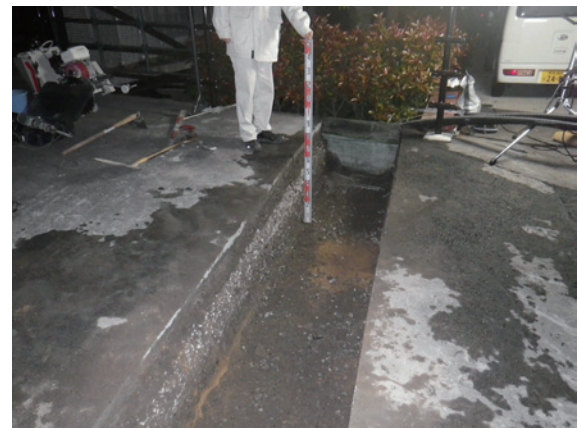
完掘状況（西から）
