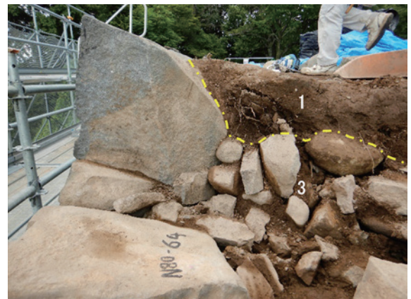
N79 解体範囲東端部（西から）
