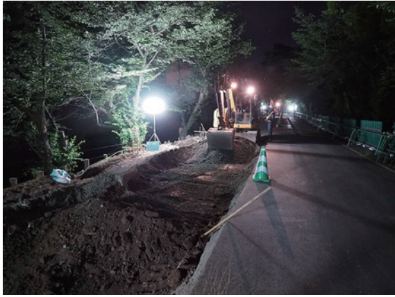
掘削状況（北から）
