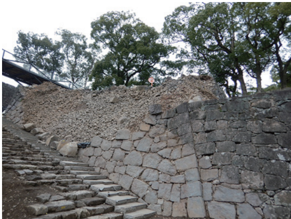
H209 石垣石材回収状況
