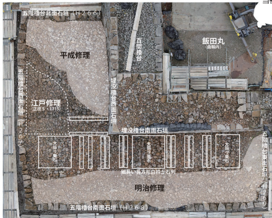
築石 14 段目解体前状況、上が北
