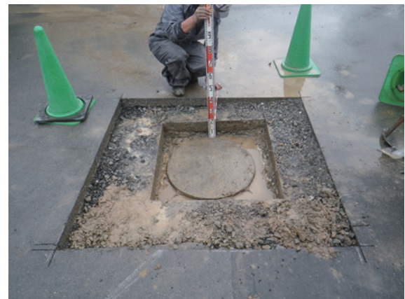
掘削状況（東から）
