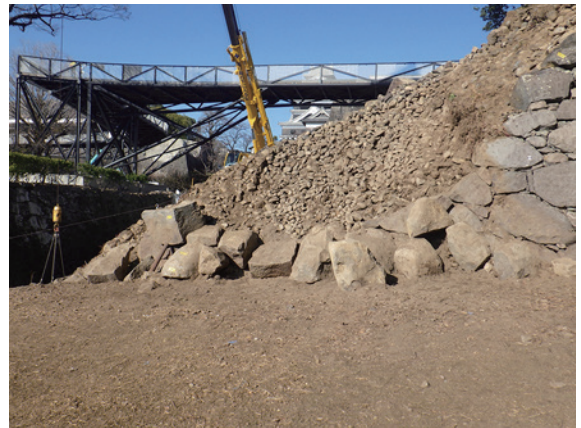
H204 石垣石材回収状況
