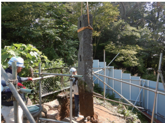
控柱回収作業 (西から)
