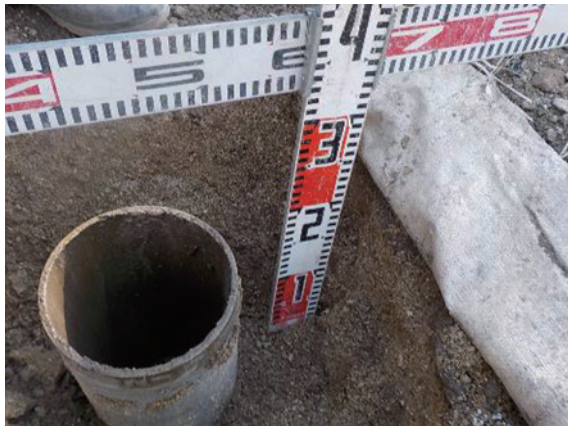
竹の丸給水蓋改修工事
