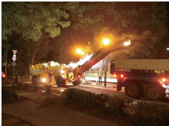
掘削状況（南から）
