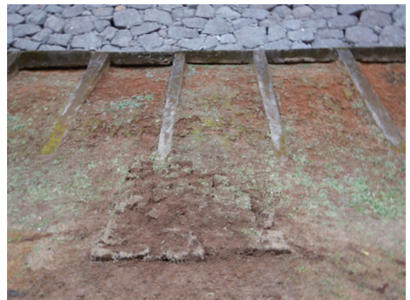
埋め戻し完了状況（北から）
