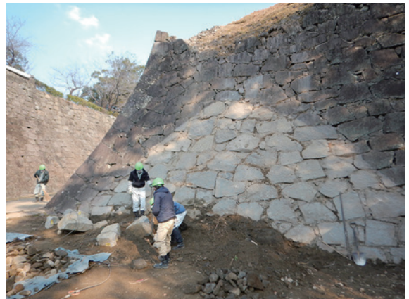
H234 石垣石材回収状況
