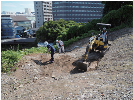
g 地点補修状況
