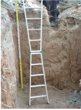
①地点 浄化槽掘削状況(東から)
