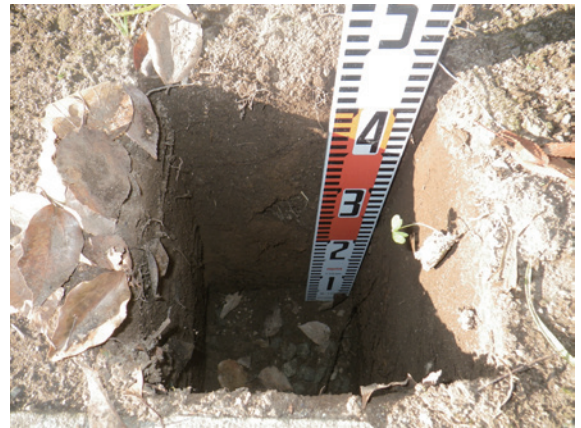
北側支柱撤去（東から）
