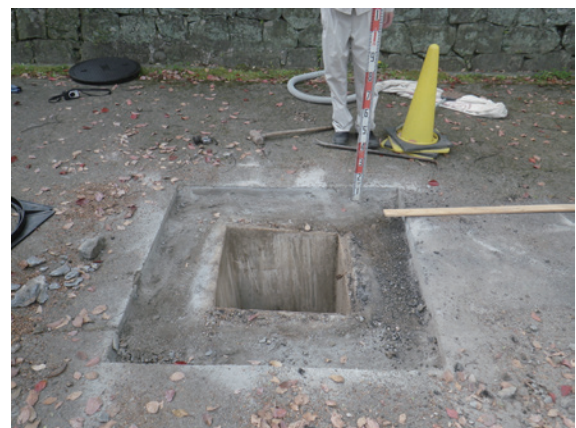
掘削状況（北から）
