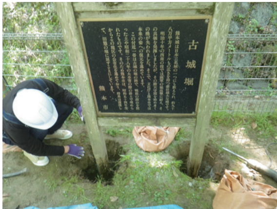
古城堀端公園 掘削状況
