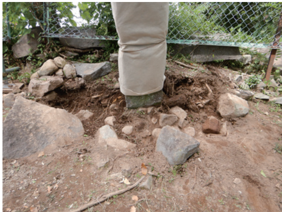
裏込め検出状況 (南から)
