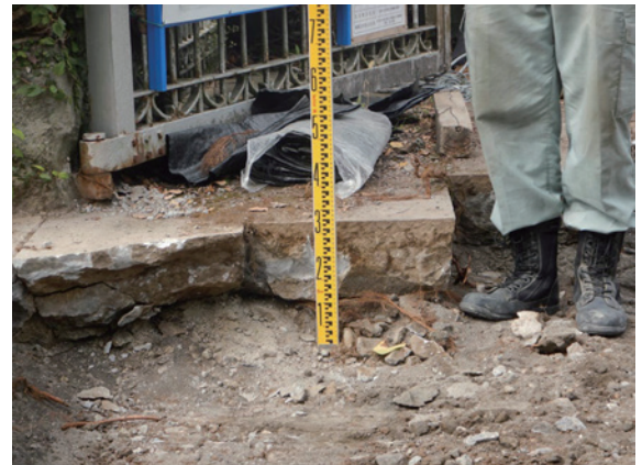
掘削状況（東から）
