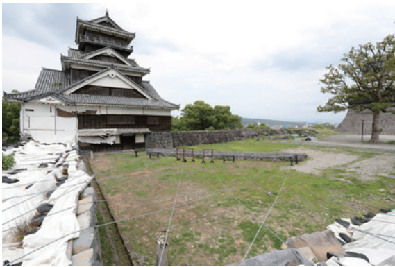
平左衛門丸発掘前状況 (南東から)
