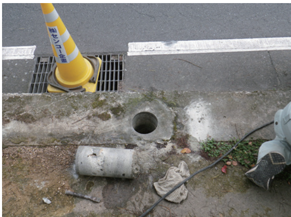
掘削状況（南から）
