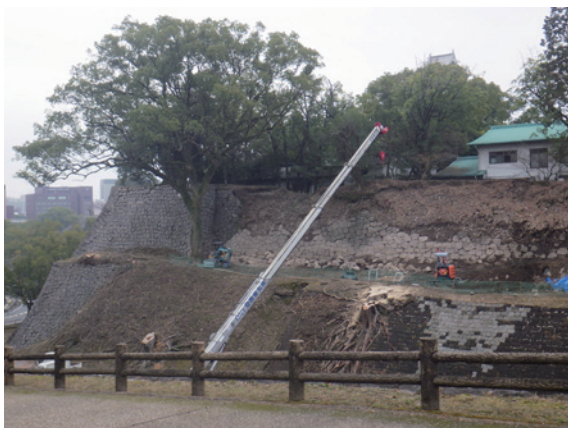
H118 石垣石材回収状況
