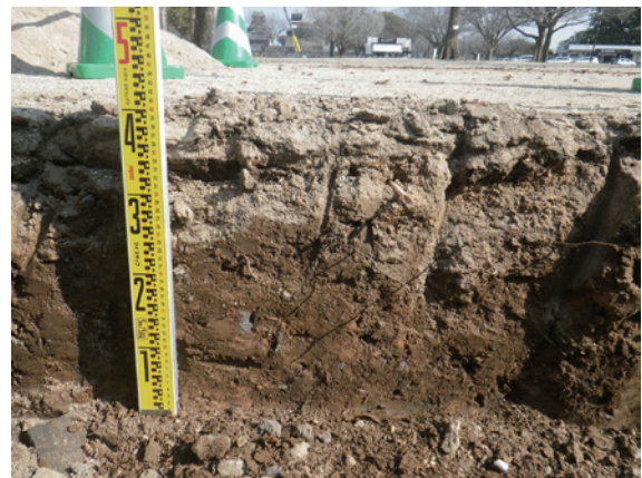
2: 境界ブロック南端から北 20 m地点 土層断面
