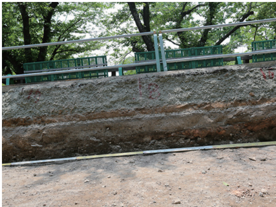
路面状況（東から）
