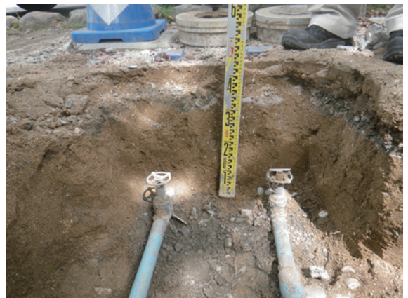
⑬地点 土層断面 (西から)
