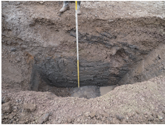
8 トレンチ土層断面（東から）
