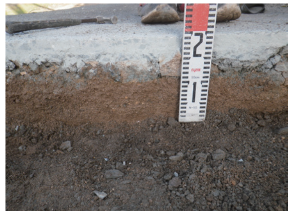
掘削断面 (南から)
