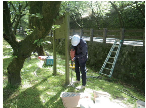
法華坂脇 掘削状況
