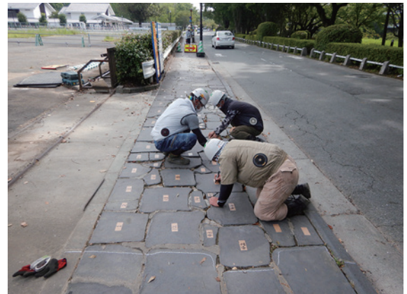
石敷き番付作業状況（西から）
