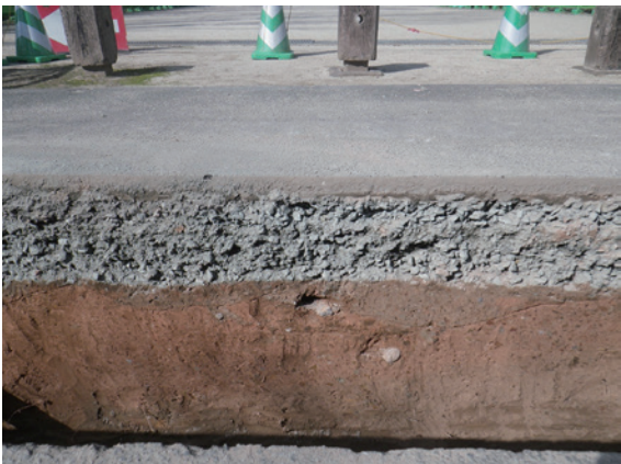
7 : マンホールNo. 4 から北 10 ~ 15 m 北壁土層断面
