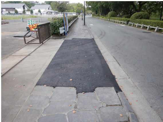
アスファルト舗装完了状況（西から）
