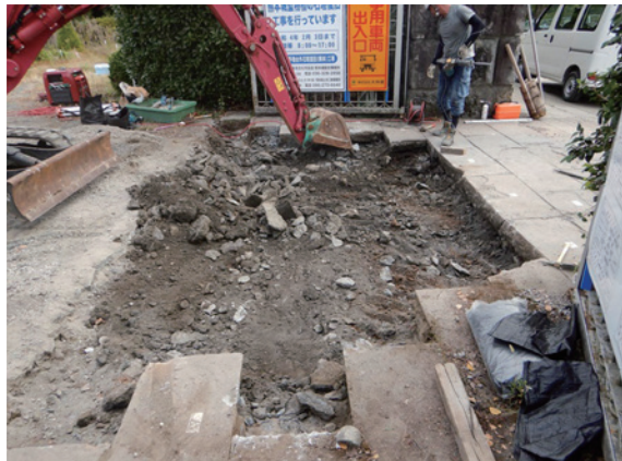
掘削状況（西から）
