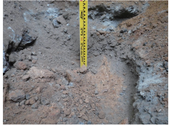
①地点 浄化槽掘削底部分
