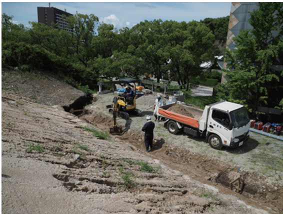
c 地点掘削状況
