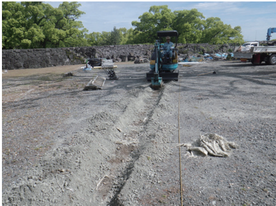
平左衛門丸掘削状況
