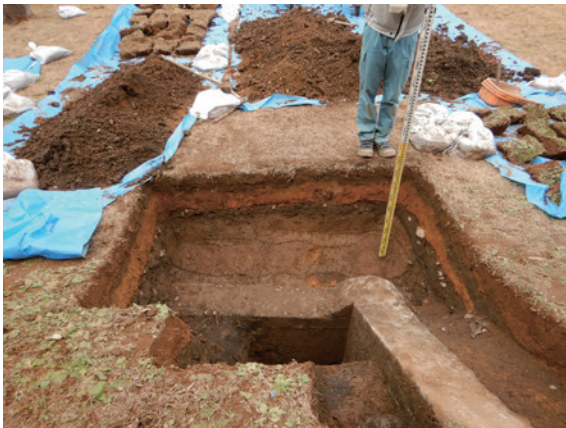
コンクリート基礎頭検出状況（南から）
