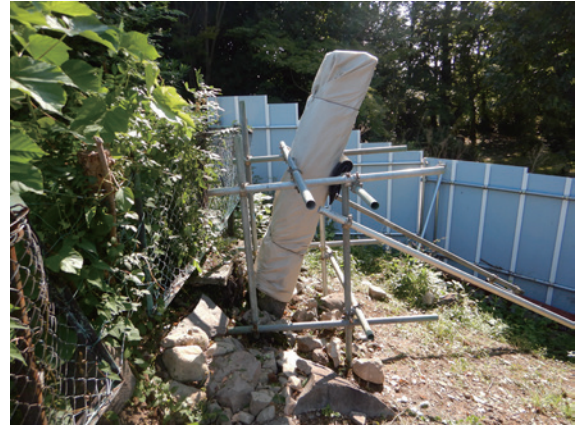
控柱養生作業後 (西から)
