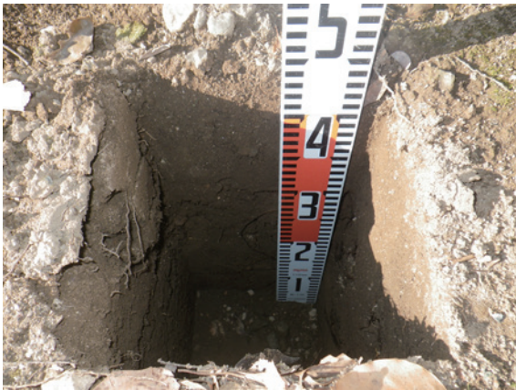
南側支柱撤去（東から）
