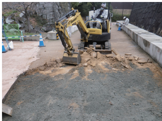
西側地点掘削状況（南から）
