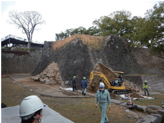
H233・H234 石垣石材回収状況
