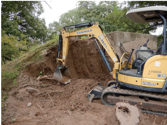
撤去作業状況（西から）
