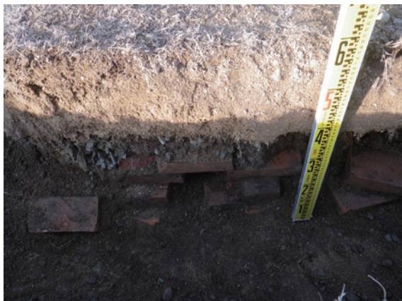
幹線 A 7: 交点 3 東 0.6 m 地点 レンガ基礎
