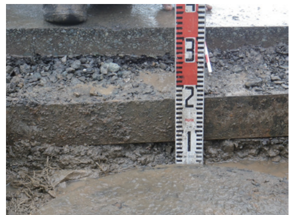
掘削断面（東から）
