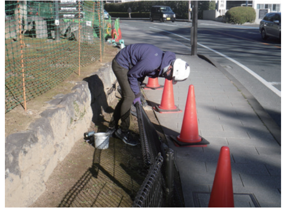
撤去作業（南から）
