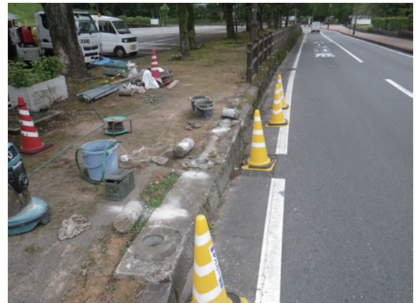
立会状況（東から）
