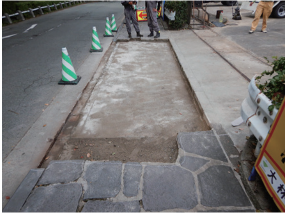
掘削完了状況（東から）
