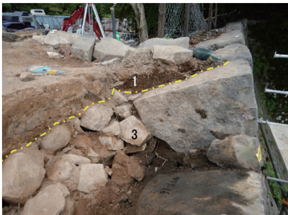
N79 解体範囲南端部（北から）
