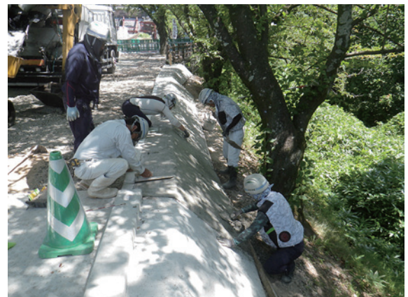
法肩工事コンクリート施工状況（南から）
