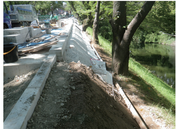
法肩工事盛土造成終了（南から）
