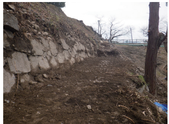
H118 石垣石材回収状況
