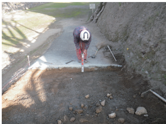
掘削状況 (南から)
