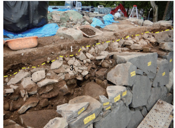
N79 解体範囲東壁土層（北西から）
