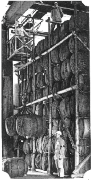
★ 倉庫クレーン作業
