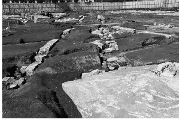
2 20号倉庫基礎（渡り廊下）（南）
