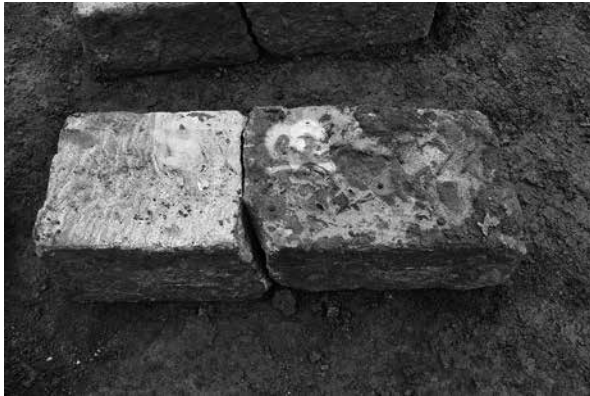
3 排水路石蓋接合状況
