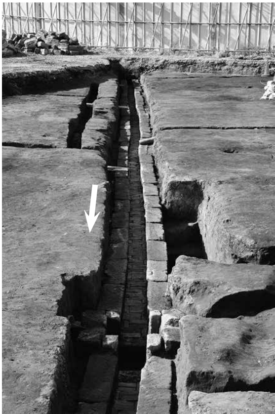
5 18号倉庫北側前面排水路 側石・底面煉瓦敷状況(東)
