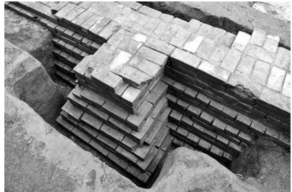
6 9号倉庫 地中基礎レンガ (南)
