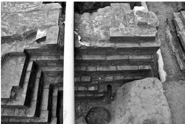
7 9号倉庫 地中基礎レンガ (南)
