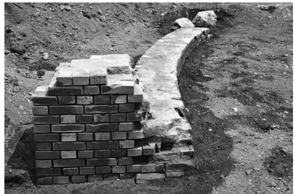
8 第三貯水池基礎 (北)
