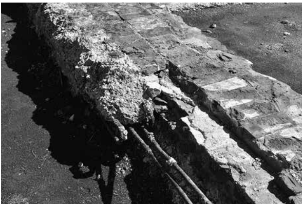
6 20号倉庫基礎 関東大震災後の補強
