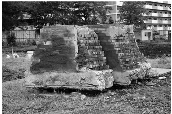
4 5号倉庫基礎レンガ保存用切り出し
