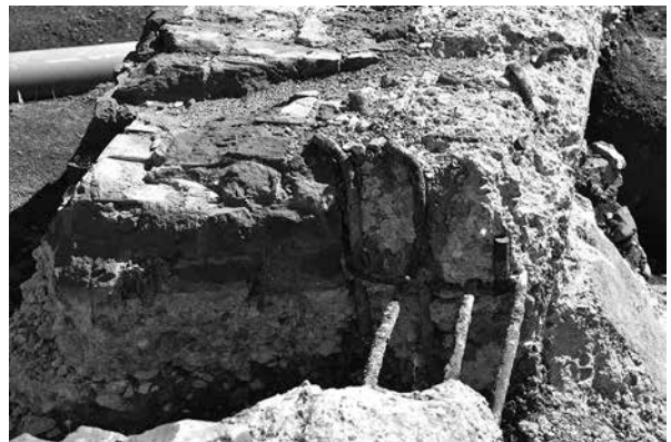
7 20号倉庫基礎 関東大震災後の補強
