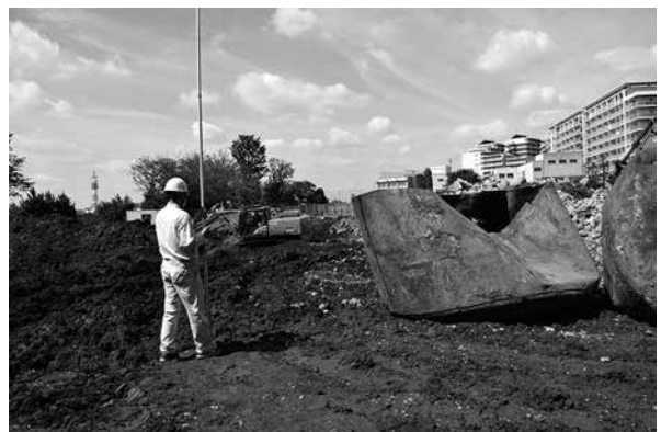
7 貯蔵タンク（解体取り上げ後）
