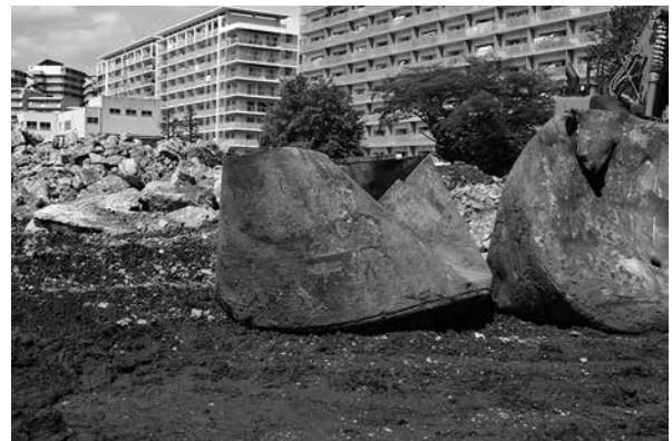
6 貯蔵タンク（解体取り上げ後）
