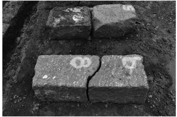
2 排水路石蓋接合状況
