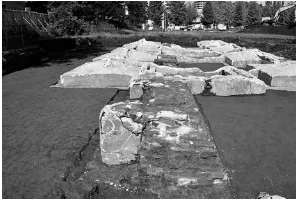
1 5号倉庫基礎レンガ(東)
