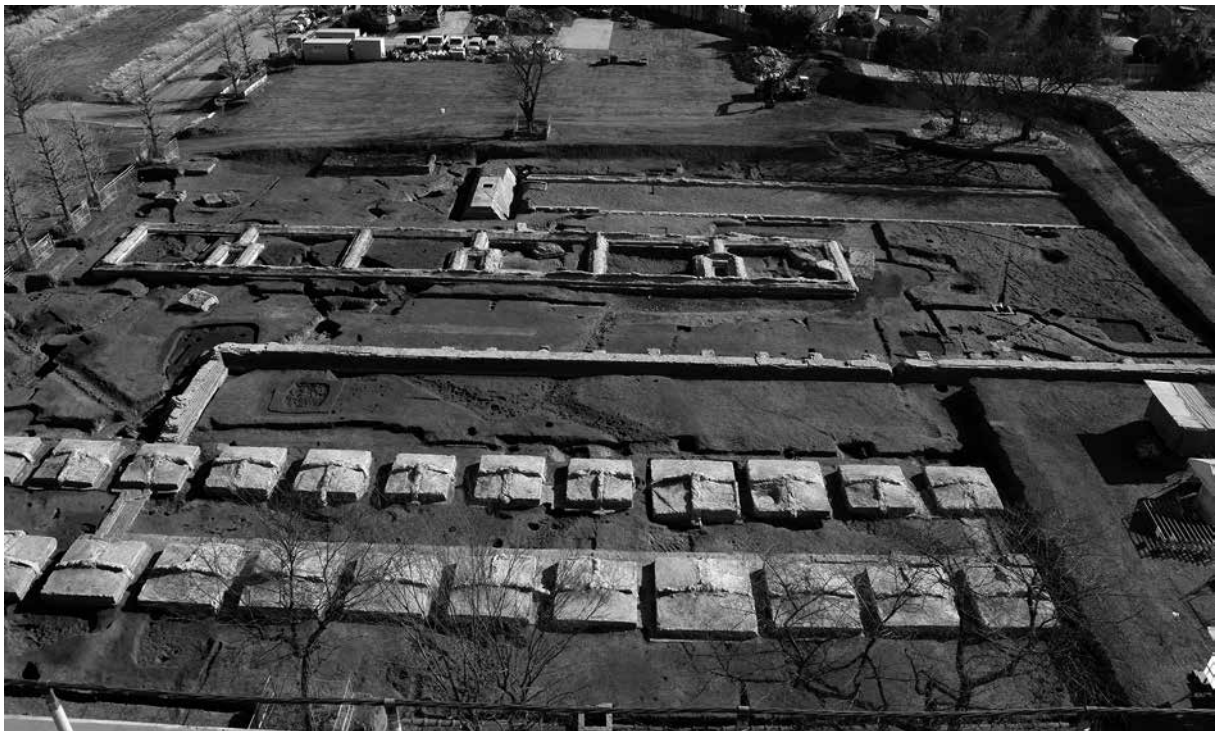
7 引き込み線・貯水タンク (北)
