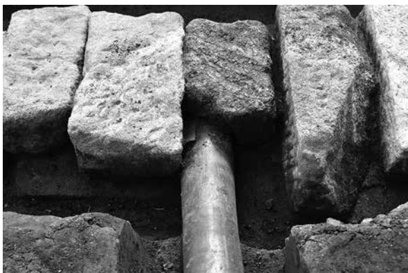
7 排水路枝管 本管への連結部
