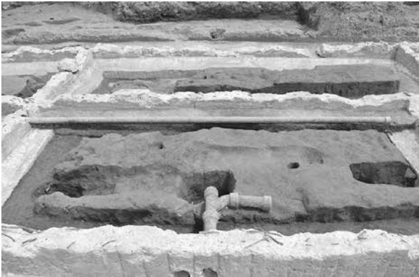
3 4A区旧38号棟 基礎内⑪(北)
