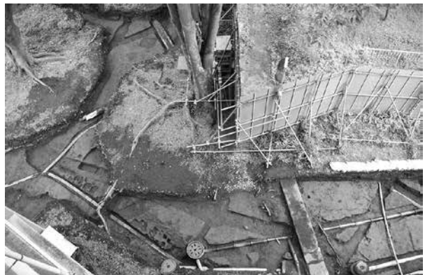
8 2B区東側 全景 (45号棟から) (南)
