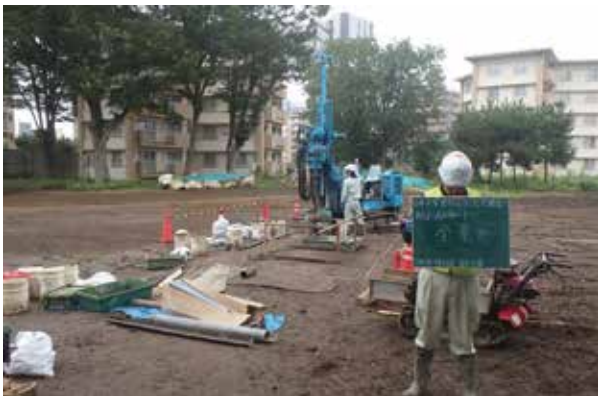
4 1区 ボーリング調査 (2020.7.31)
