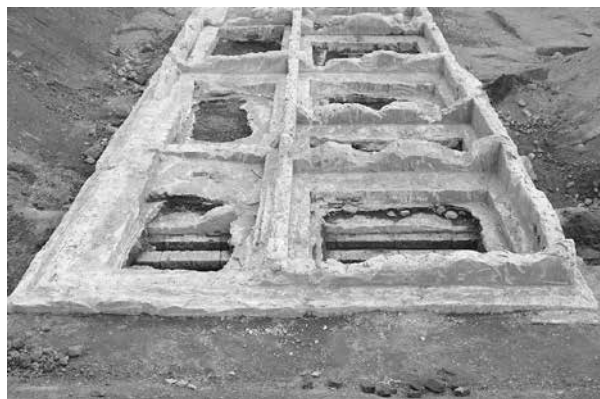
8 4B区旧35号棟 基礎内南侧 (南)
