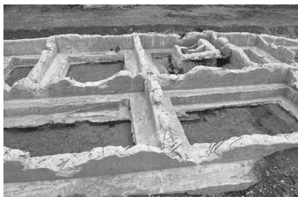
1 4B区旧35号棟 基礎内③ (西)
