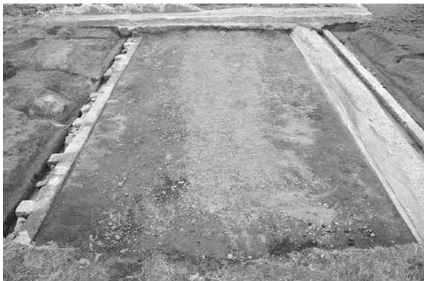
7 4B区旧35号棟 西侧①(西)
