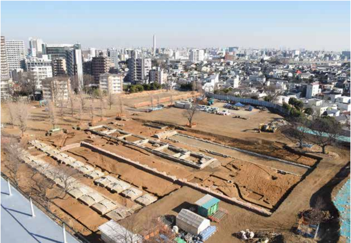
1 3号棟屋上からの3区遠景 (2021.01.14)
