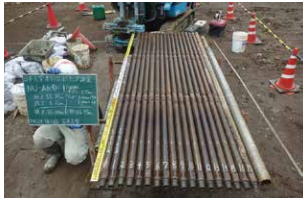
5 1区 ボーリング調査 (2020.7.31)
