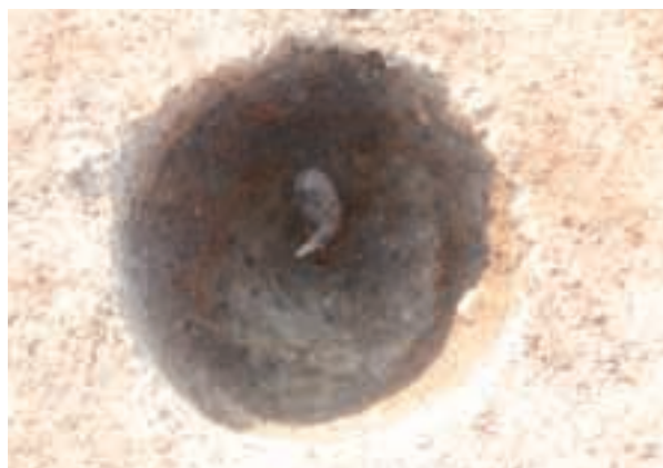
5区 SB06_SP5015（北より）
