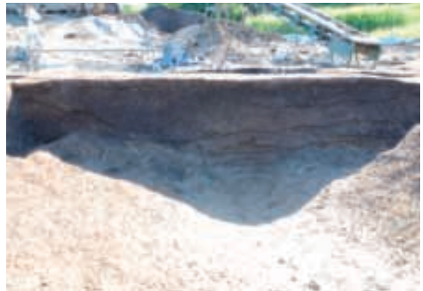
4区 SD093 土層 (西より)
