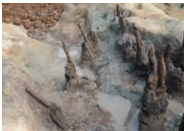
6区 SG04 外側護岸施設 (西より)
