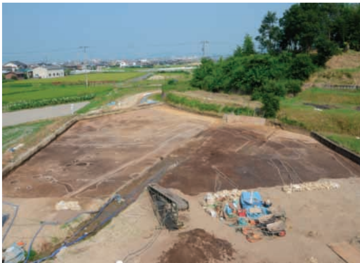
3区第1面全景（西より）
