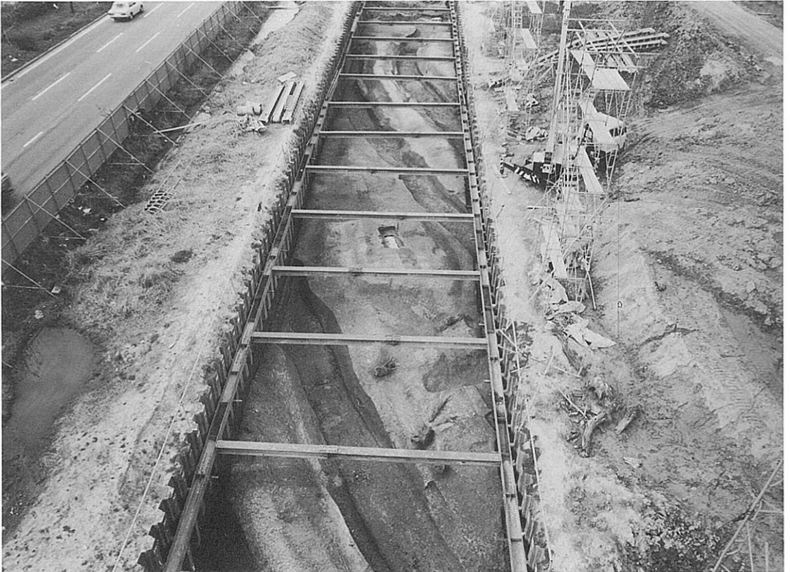
Bトレンチ 環濠状遺構 (南から)
