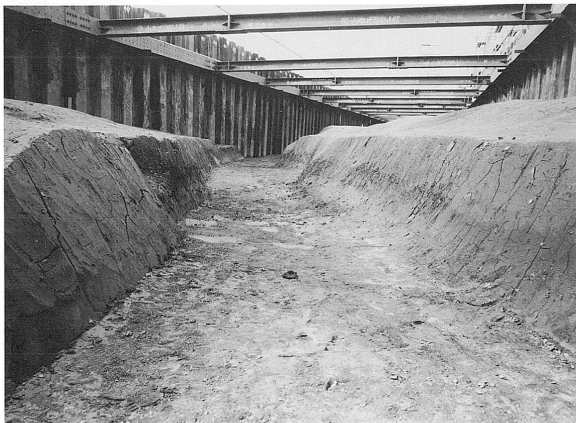
Bトレンチ 溝6 (南から)
