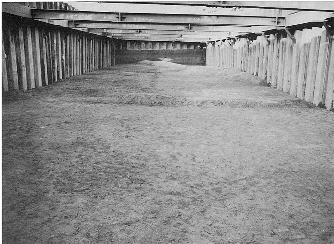
Bトレンチ 水田 (南から)
