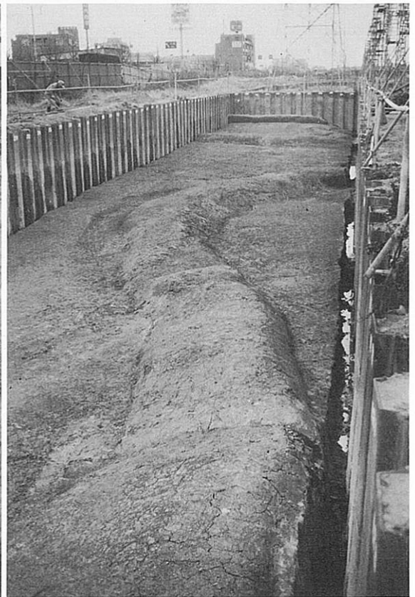
Aトレンチ 畦畔2 (南から)
