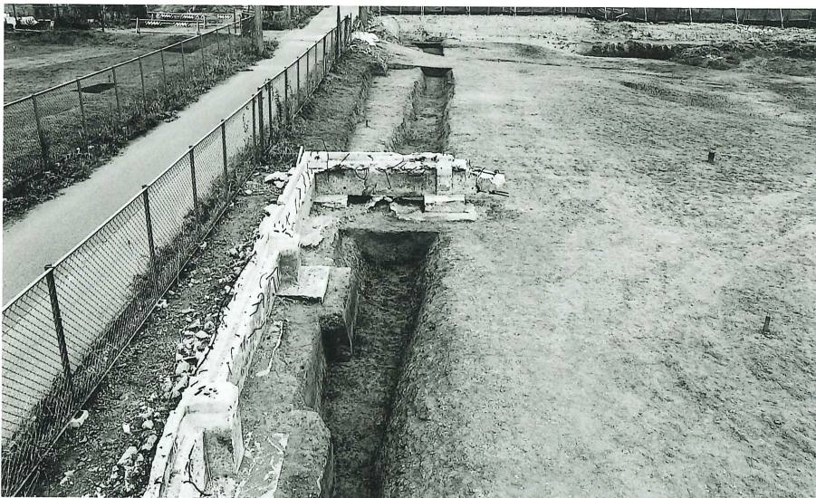
第1号溝（調査区南側）
