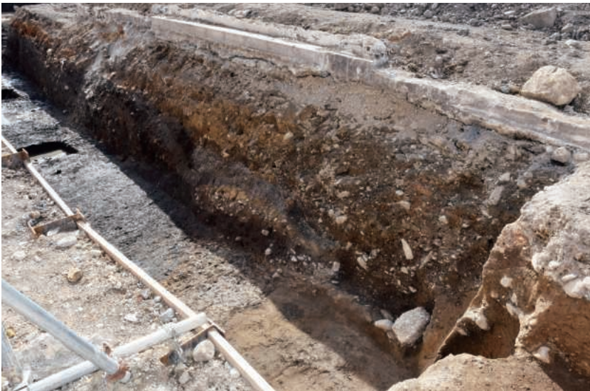
中堀断面A-A' (北東から)
