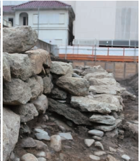
石垣屈曲部（東から）
