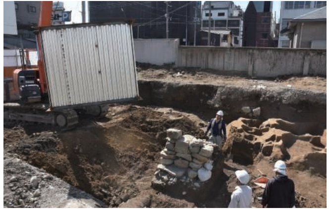
①鉄枠設置作業状況
