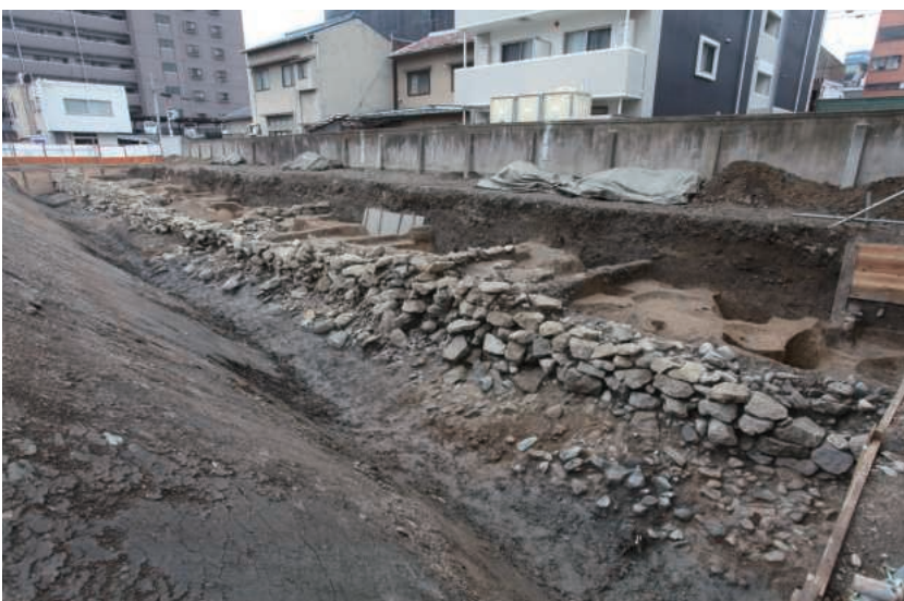
石垣（北西から）
