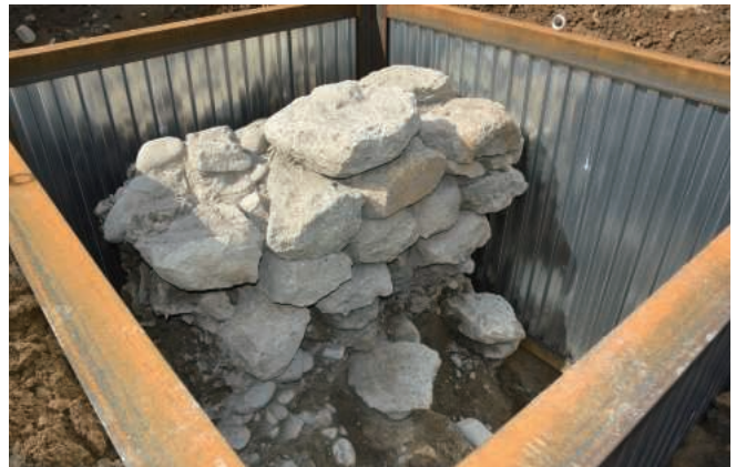
②鉄枠設置状況
