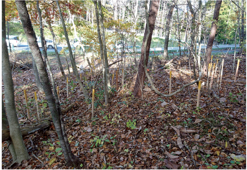
ボーリング調査状況
