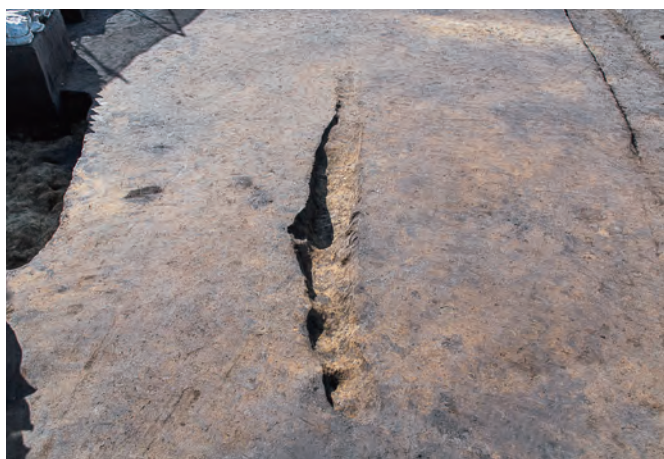
3. 4号溝全景(北東から)
