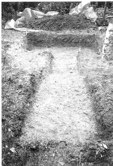
T-3 (北東から)
