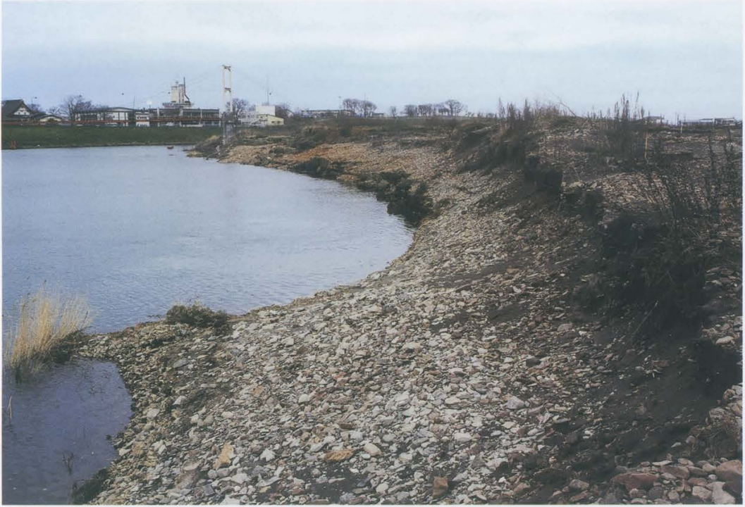
1. 常呂川 2001年9月 集中豪雨により、露呈した河川礫
