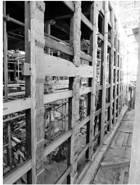
軸組み完了後
