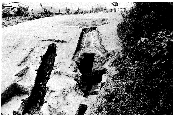
第1号窯跡天井・掘り方確認状況
