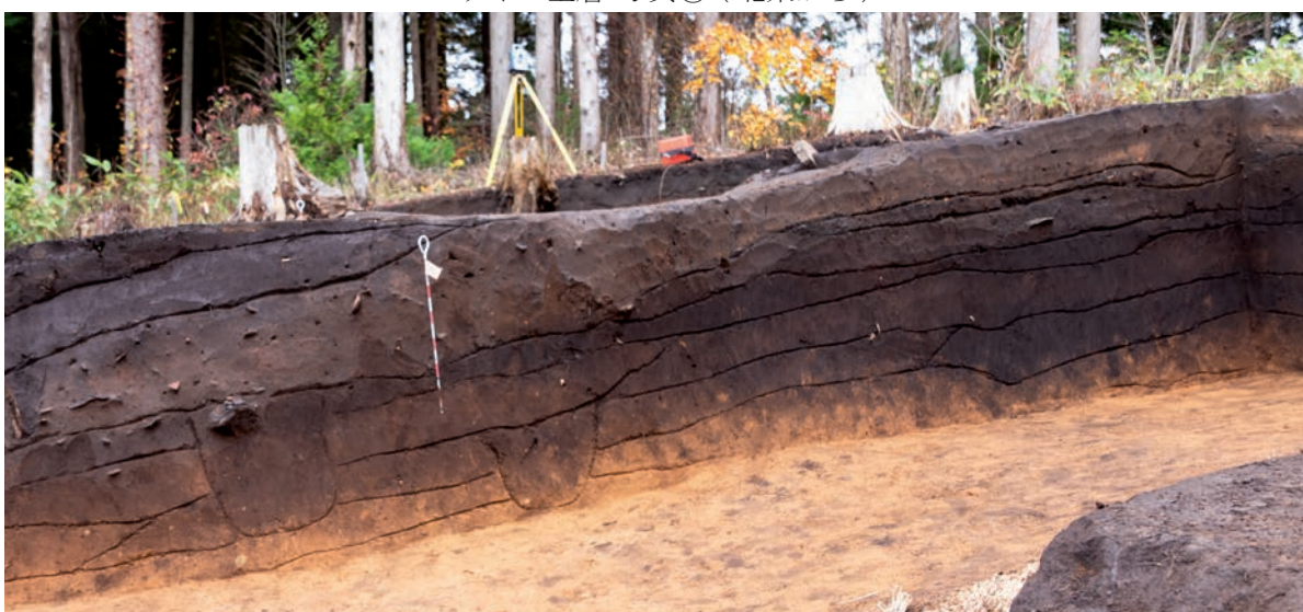
Bライン土層 写真④（東から）
