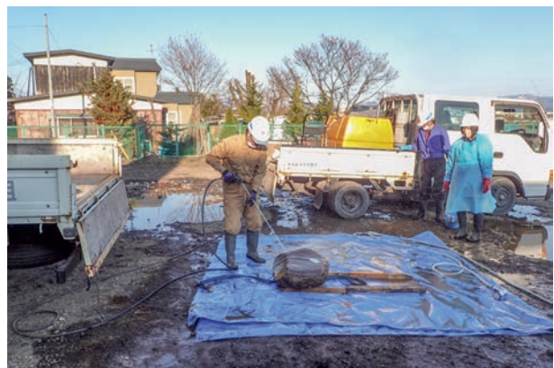
高圧洗浄機による礫洗浄
