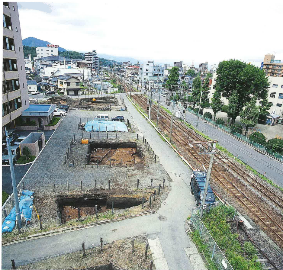
東田室遺跡第3次調査 I-1~3区 (東から)
