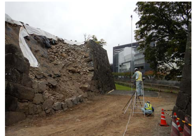
石垣測量作業状況（西から）
