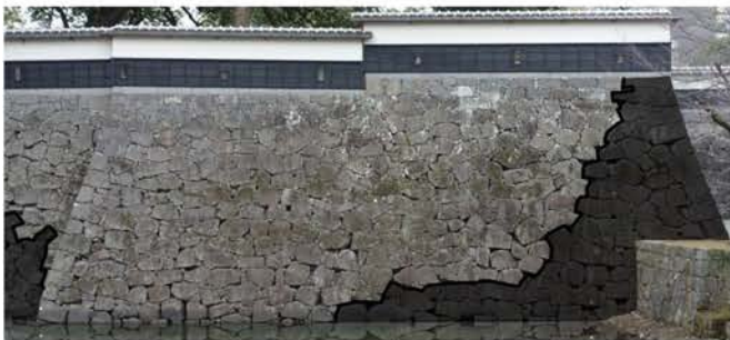
H594（上）、H596（下） 平成 28 年熊本地震前震後崩落範囲
