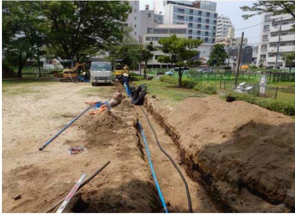
写真5 作業風景（北から）
