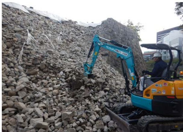
裏込め回収作業（北西から）
