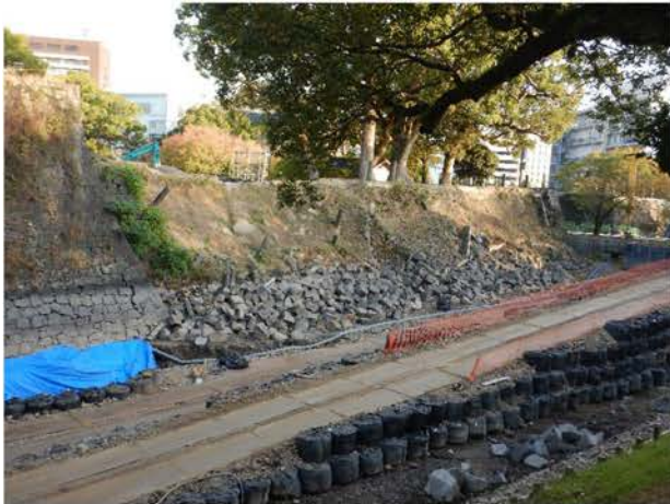
H596・H594 石垣崩落状況（北西から）
