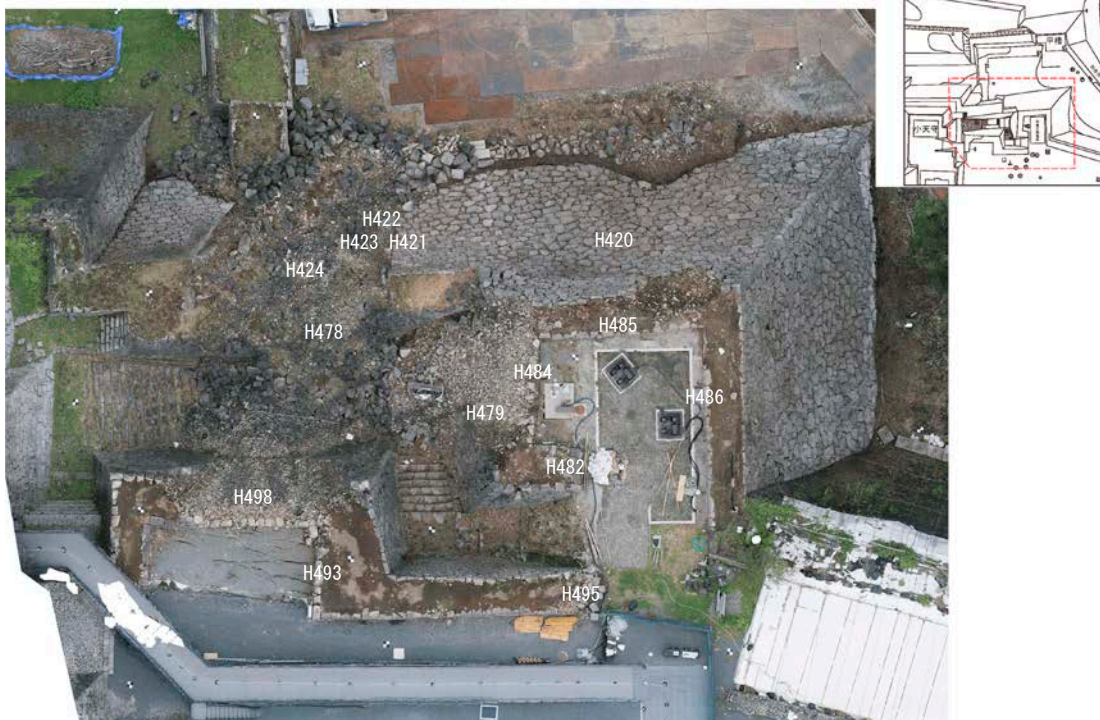
石門周辺石垣崩落状況（上が北）
