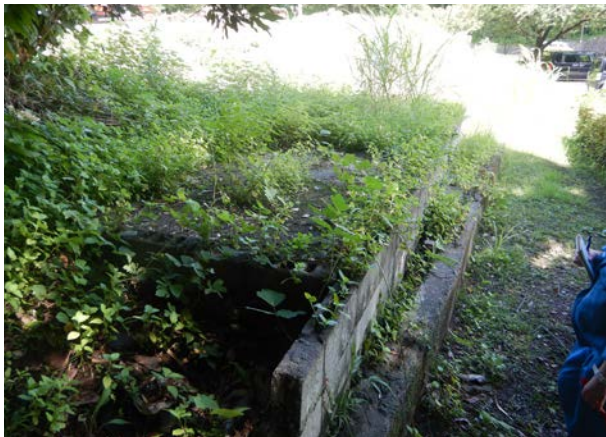
空洞ブロック撤去前 (西から)
