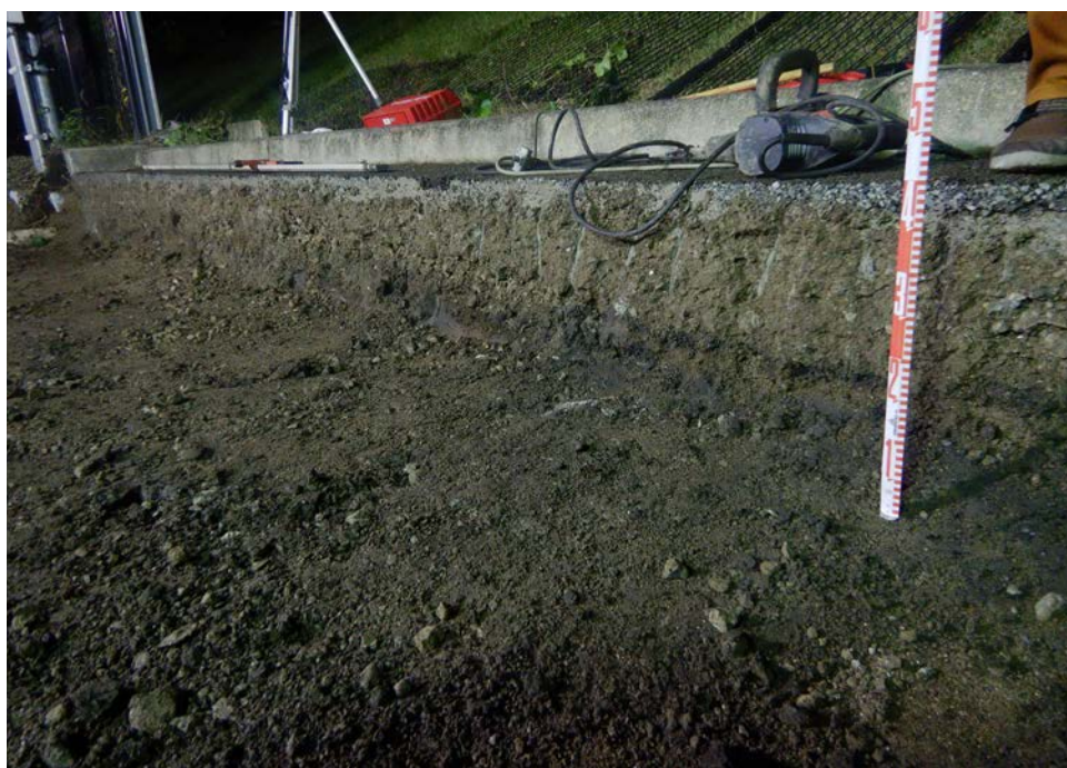
掘削完了後北壁（南東から）
