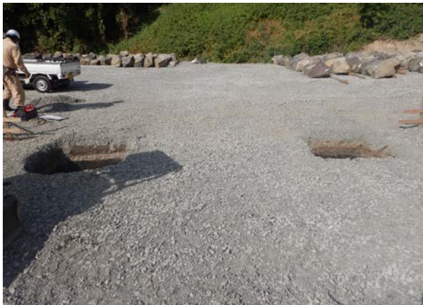
門扉部分掘削完了後（東から）
