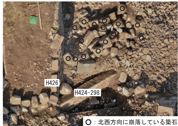
H424 3層目崩落状況（上が北）
