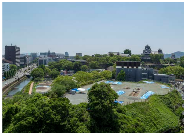
調査地遠景（東から）
