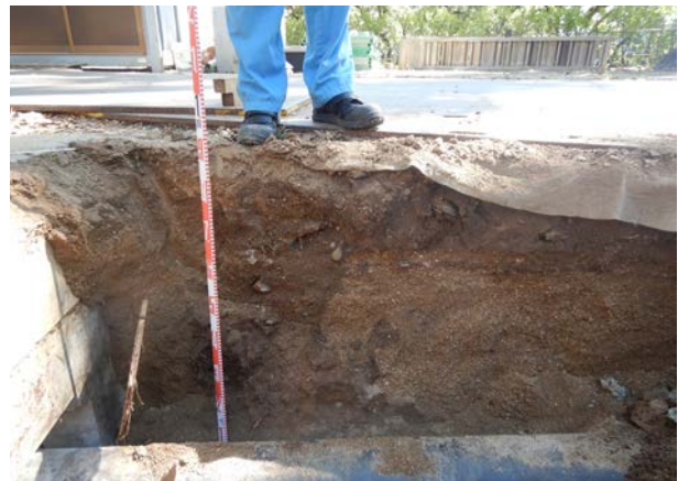
掘削箇所東壁(西から)
