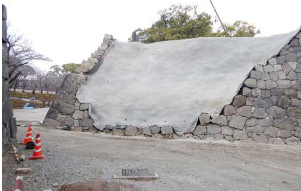
水洗後石垣面モルタル吹き付け状況（南から）
