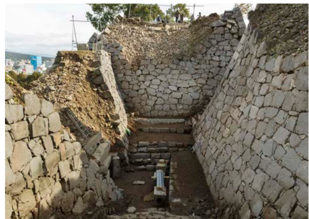
石門南側 崩落石材回収後（西から）
