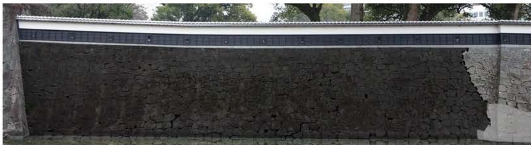
H594（上）、H596（下） 平成 28 年熊本地震前震後崩落範囲
