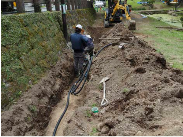
写真 12 作業風景 3 (北東から)
