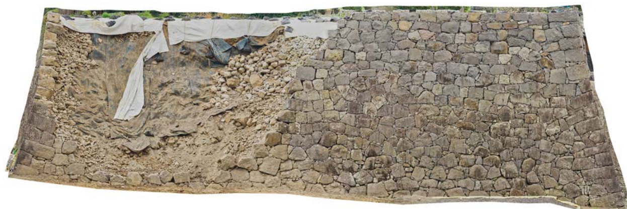
H569 崩落石材回収後立面オルソ図
