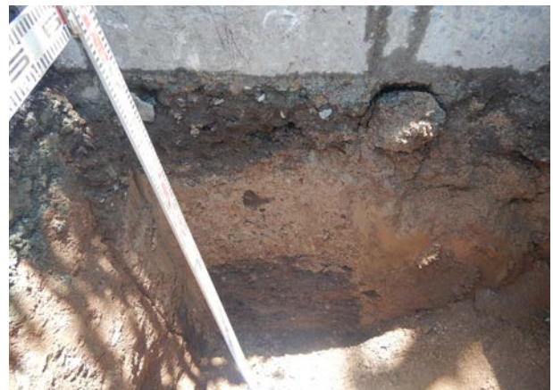
水道引込管閉塞箇所東壁 (西から)
