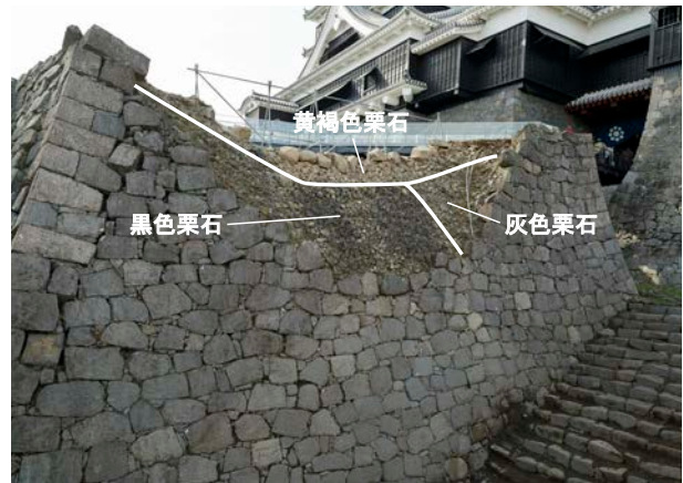
H498 背面構造（北東から）
