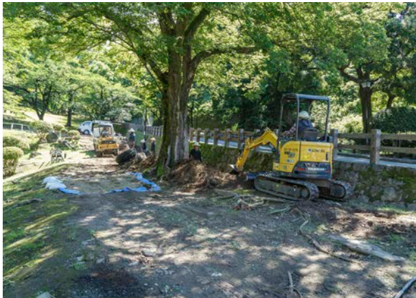
写真 13 作業風景 2 (西から 写真奥が法華坂)
