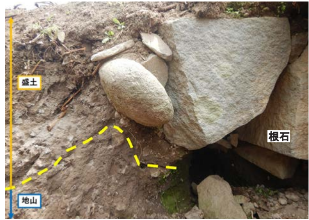
H438・H439 隅角部根石前の地業（北西から）
