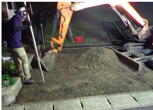
掘削状況（南から）
