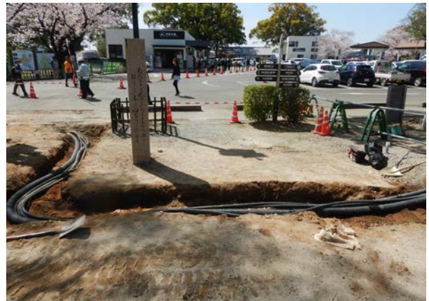
掘削完了後（北から）
