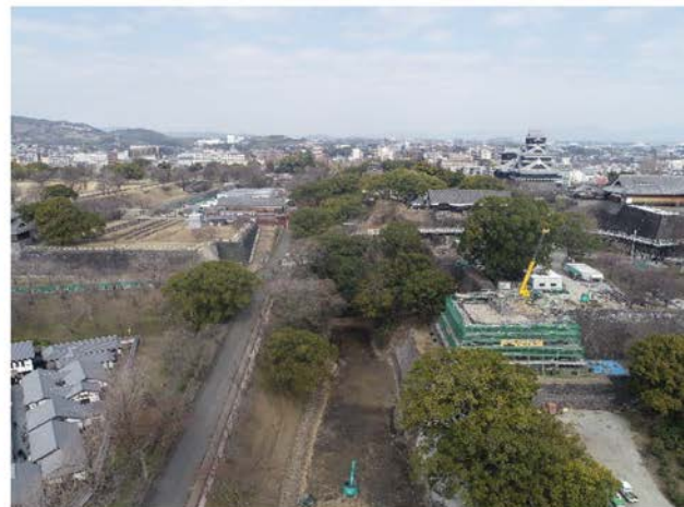
備前堀浚渫作業完了状況（南から）
