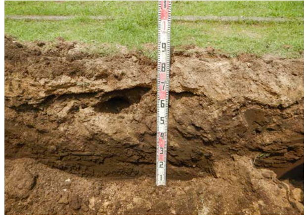
写真6 土層断面（東から 最下層に水害発生土）
