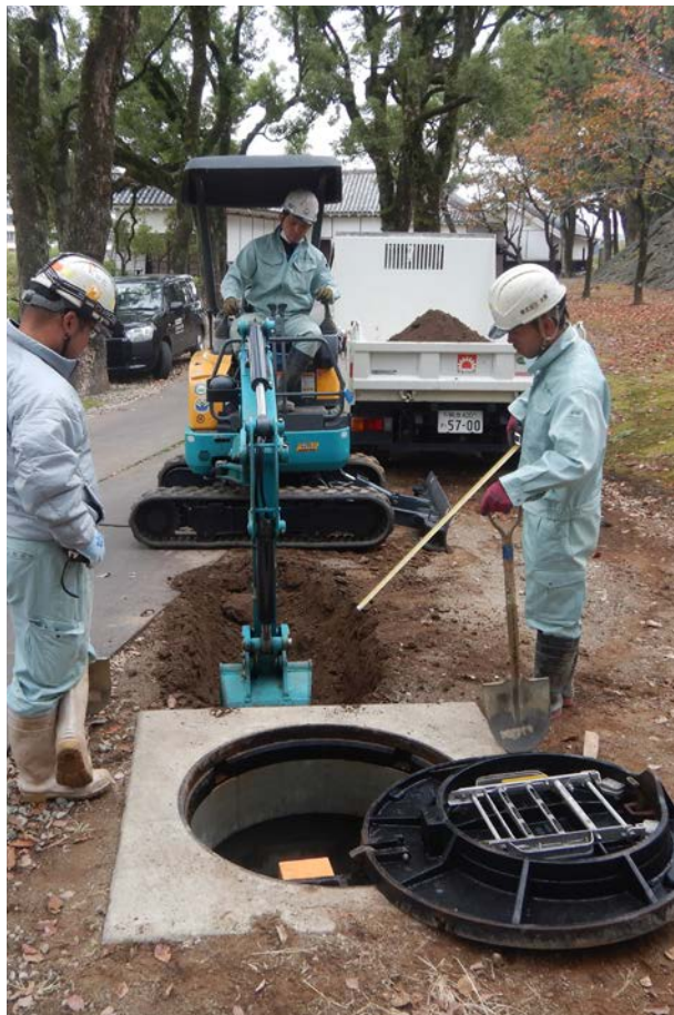
掘削作業状況(北から)
