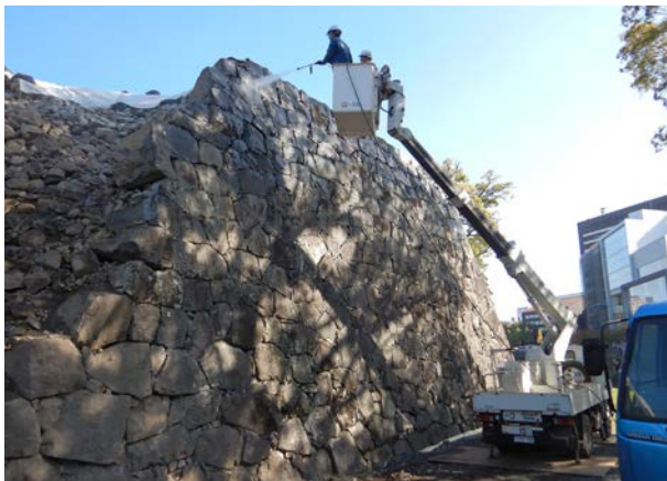
石垣面水洗状況（南西から）
