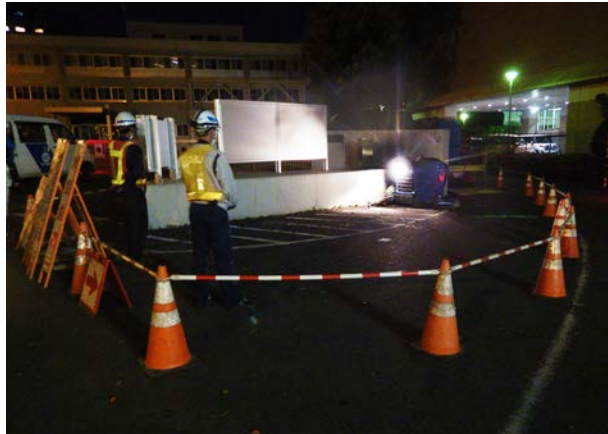
掘削箇所南側 遠景 (南南西から)
