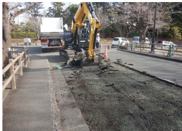
掘削作業状況（南から）
