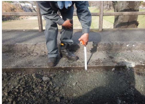
掘削完了後西壁（東から）
