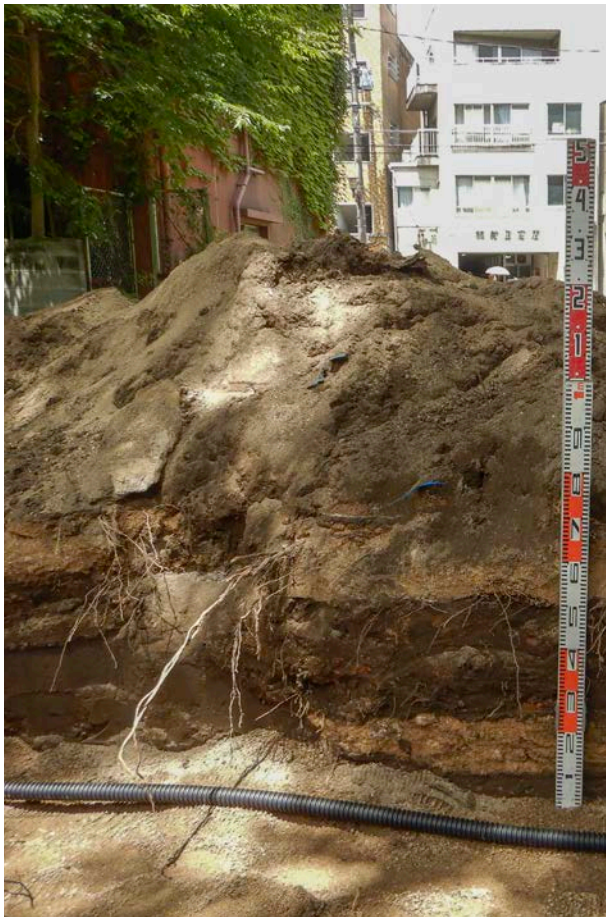
写真3 土層断面（東から 最下層に水害発生土）
