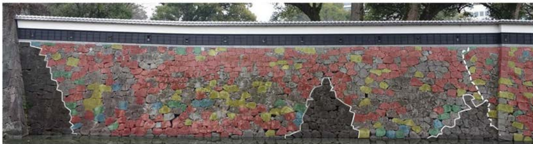
H594（上）、H596（下） 石垣の崩落範囲と原位置、崩落層位の照合結果（西から）
