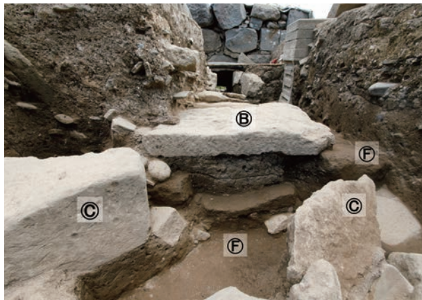
溝③・②・⑥設置状況と排水溝④内埋土堆積状況(南西から)
