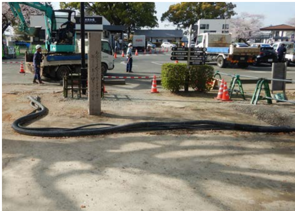
掘削作業前（北から）
