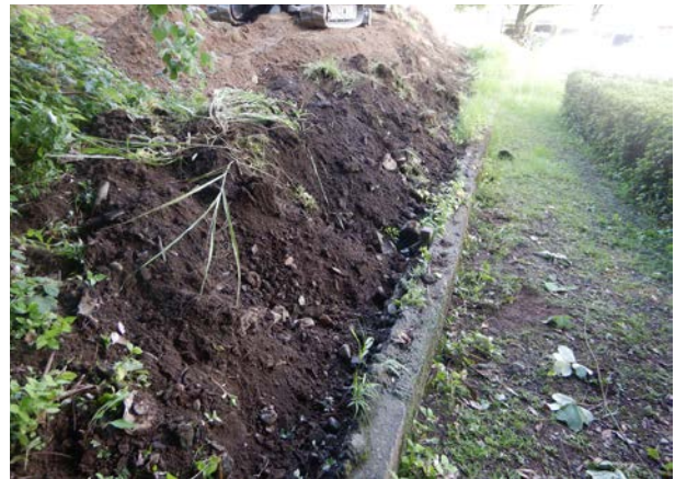
空洞ブロック撤去後 (西から)
