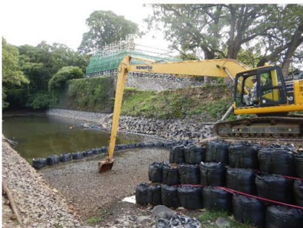
備前堀浚渫作業状況（南西から）
