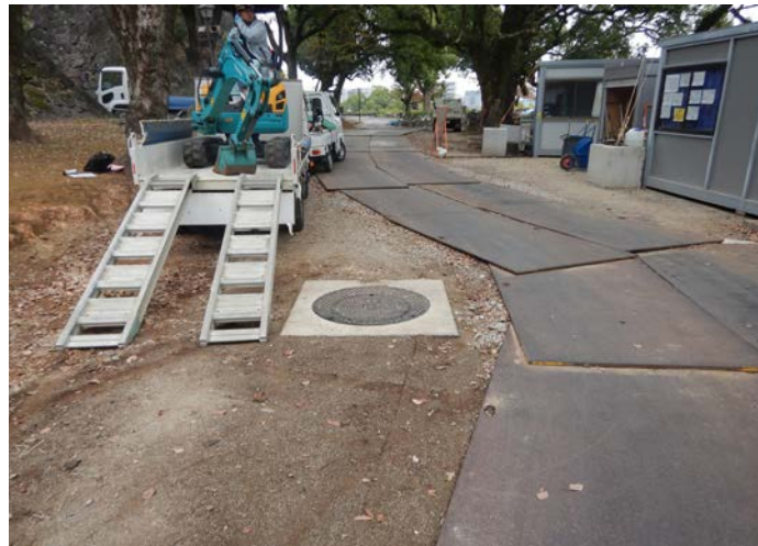
掘削前作業状況(南から)
