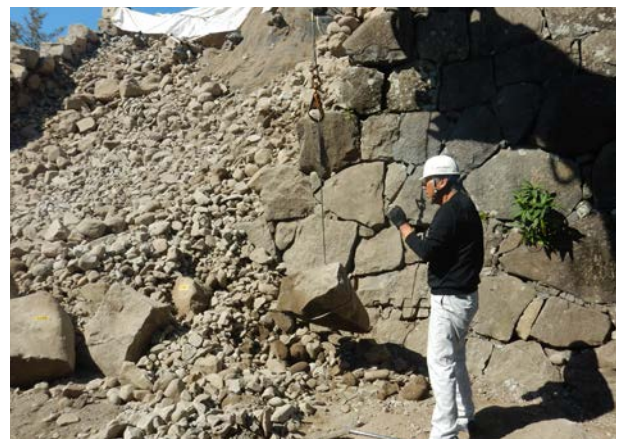
崩落石材回収状況（南から）
