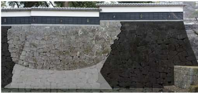
H596・H594 石垣崩落状況（北西から）
