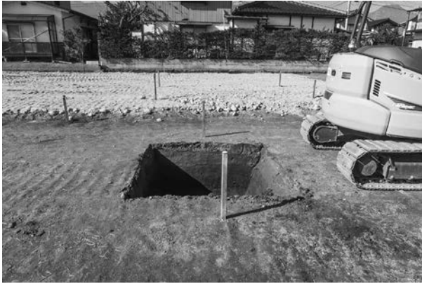
3 トレンチ完掘（東から）
