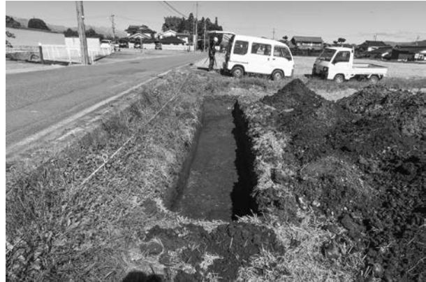
4 トレンチ完掘（南から）
