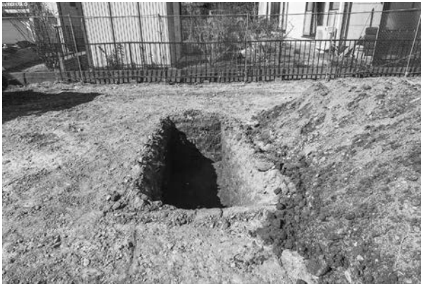
9 C トレンチ完掘 (東から)
