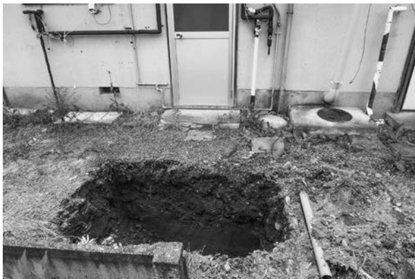
7 C トレンチ完掘（北から）
