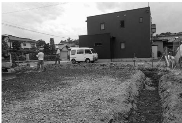
1 工事立会掘削（北西から）
