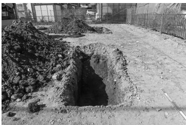
7 B トレンチ完掘（東から）
