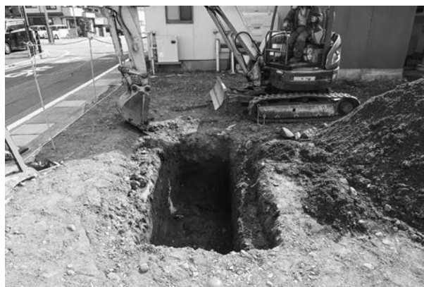
4 トレンチ完掘（西から）
