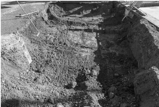
5 C トレンチ全景 (西から)
