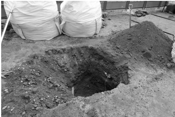
13 F トレンチ完掘 (西から)
