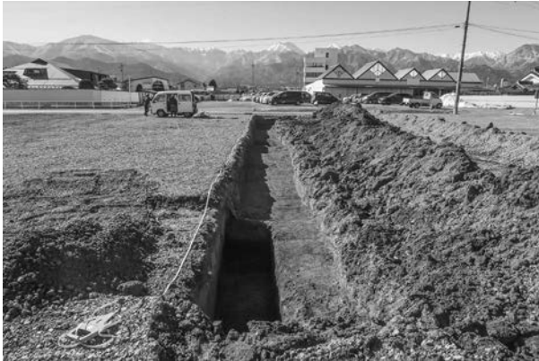
16 D トレンチ全景 (東から)
