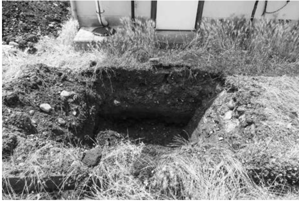
3 A トレンチ完掘（北から）
