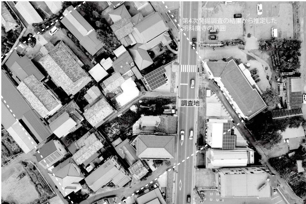
1 調査地全景（上が北東）
