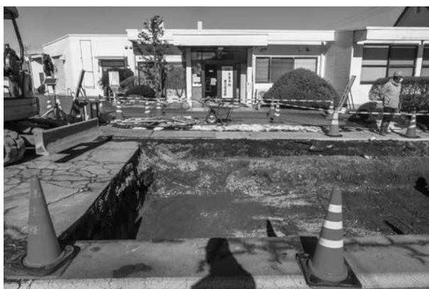
13 Gトレンチ全景 (南から)
