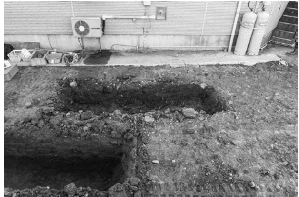
2 A トレンチ完掘 (北東から)
