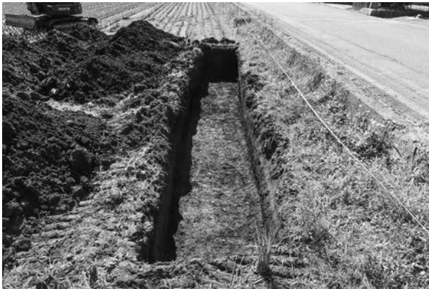
5 トレンチ完掘（南から）
