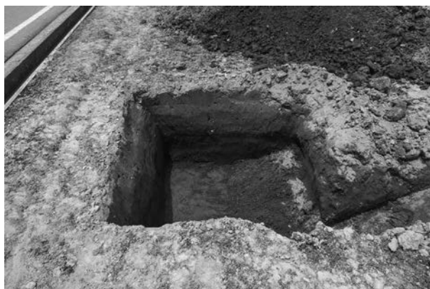
7 B トレンチ完掘（東から）
