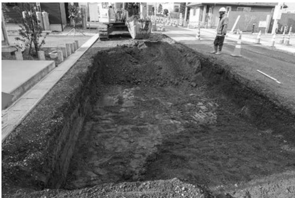
7 D トレンチ全景 (東から)
