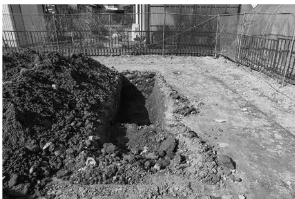
5 A トレンチ完掘（東から）
