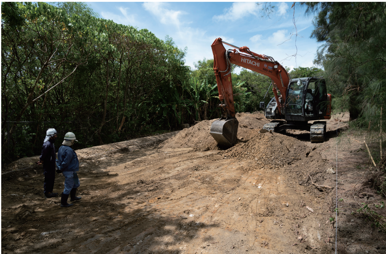
重機掘削作業
