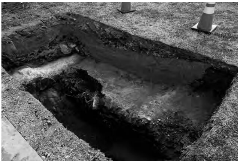
写真10 T-5 完掘 北西から
