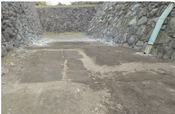
6 R区埋め戻し完了（西から）
