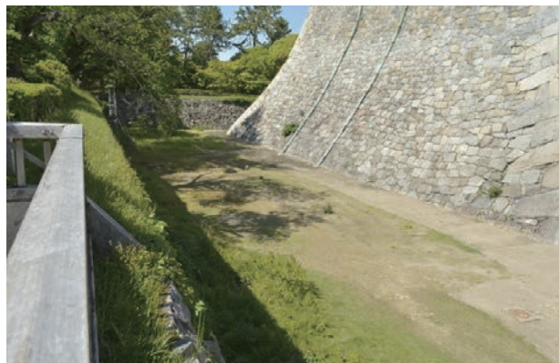
2 調査前状況（内堀西側）（南から）
