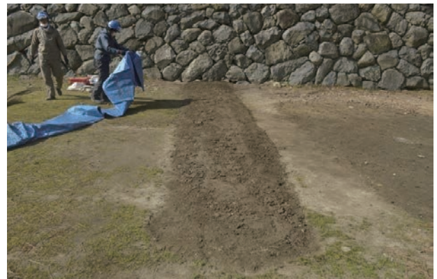
7 V区埋め戻し完了（東から）
