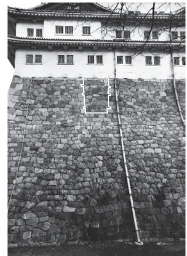
大天守台西面の「切り欠き」 (写真内白線部分)
