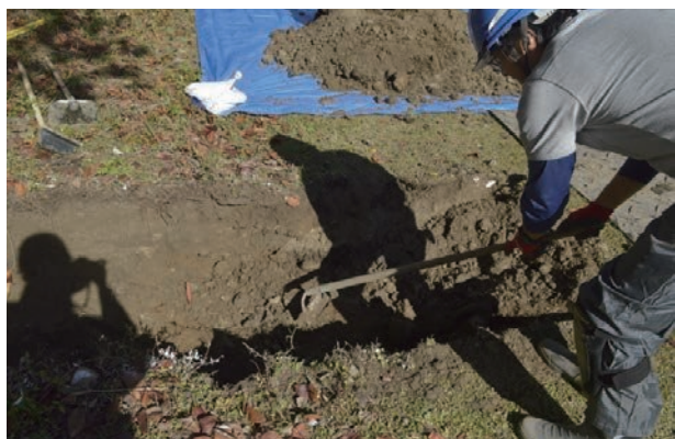
6 T区掘削状況（南から）
