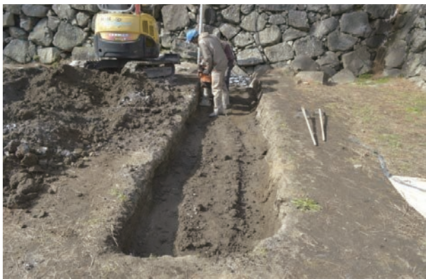
4 S区埋め戻し作業（東から）
