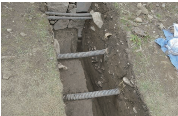
5 石垣直下の状況 (南東から)
