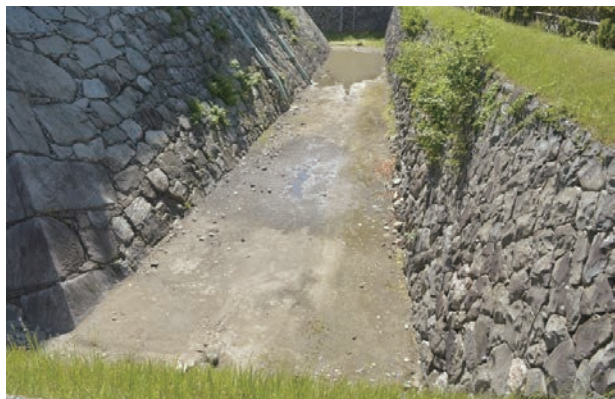
1 調査前状況（内堀北側）（東から）
