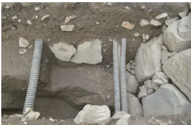
4 石垣裾部状況 (北から)
