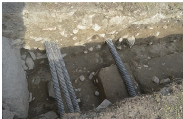
6 T区石垣裾部（南から）
