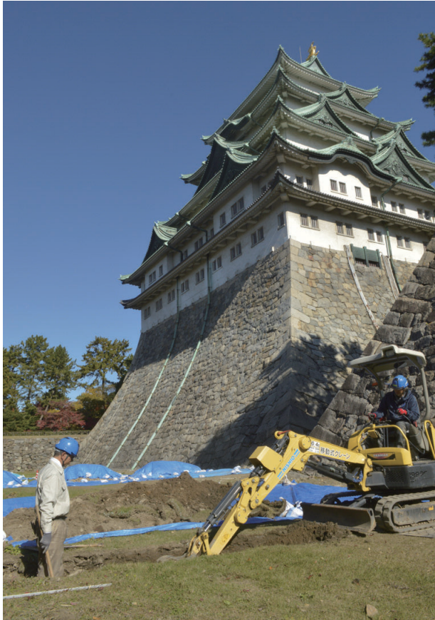
1 V区掘削状況（南西から）
