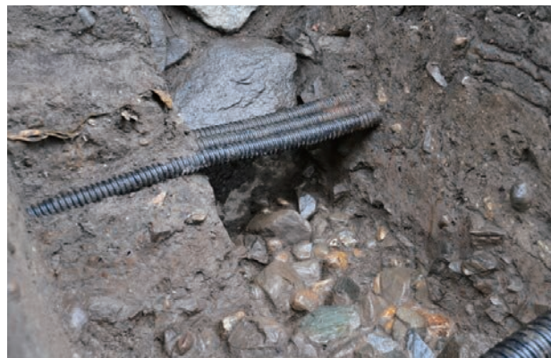
6 W区東西トレンチ御深井丸側石垣前面（南東から）
