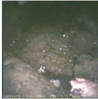
⑧ 深さ 0.2m 円礫が詰まる
