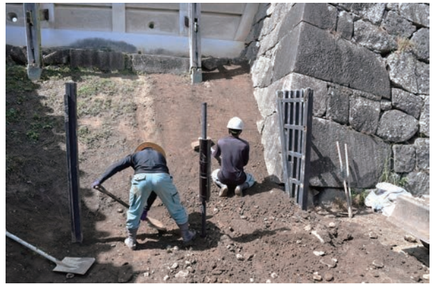
図1-8 埋戻し状況
