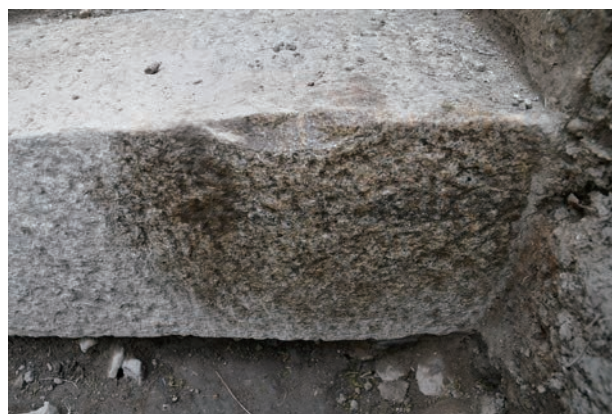
5 調査区3 切石側面検出状況（西から）
