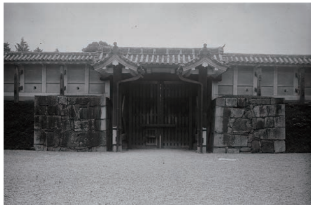
図4-6 ガラス乾板写真2（表二の門背面）
