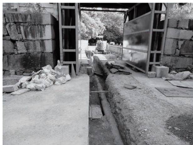
図4-22 表二の門周辺調査状況
