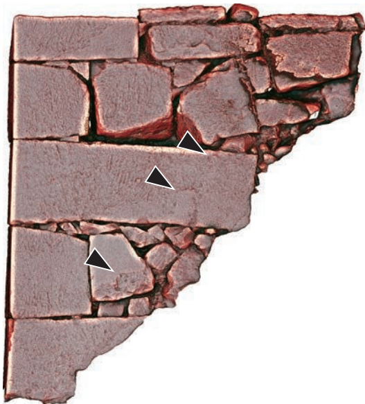
調査区5石垣面可視化処理画像
