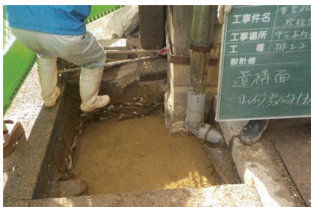
図1-3 埋戻し状況
