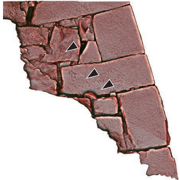
調査区6石垣面可視化処理画像
