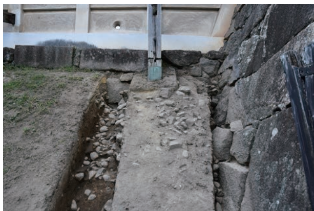
2 調査区6 控柱根固め検出状況（東から）
