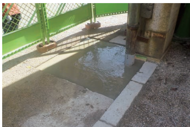
図1-4 アスファルト打設状況
