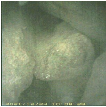
① 深さ 0.3m 円礫が詰まる
