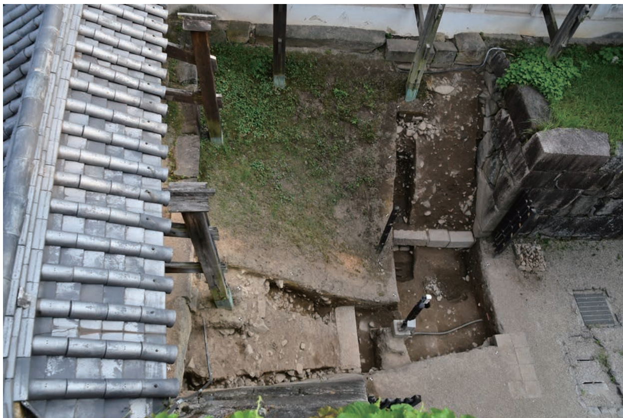
1 第2次調査 調査区3・4完掘状況（北から）
