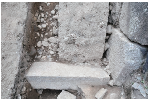
4 調査区6 切石検出状況（東から）
