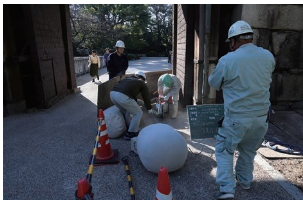
図1-1 アスファルト除去状況
