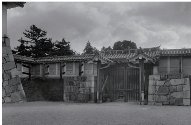
図4-5 ガラス乾板写真1（表二の門背面）
