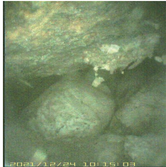
⑤ 深さ 0.1m 石段（上）の下に円礫が詰まる
