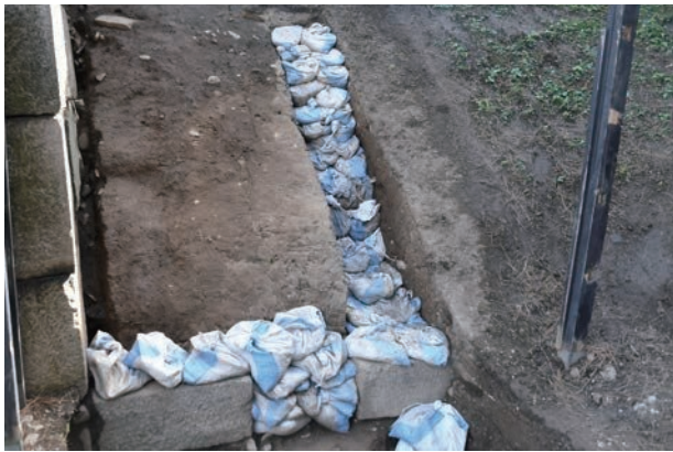
図1-7 遺構面土のう養生状況
