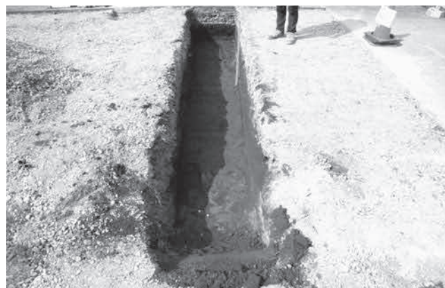
写真58 B1地点北側配線部掘削状況(東より)
