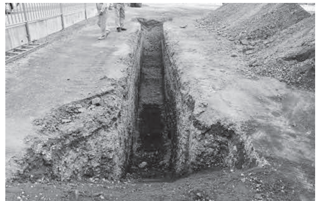
写真75 近世・近代堆積層の確認状況4 (北より)
