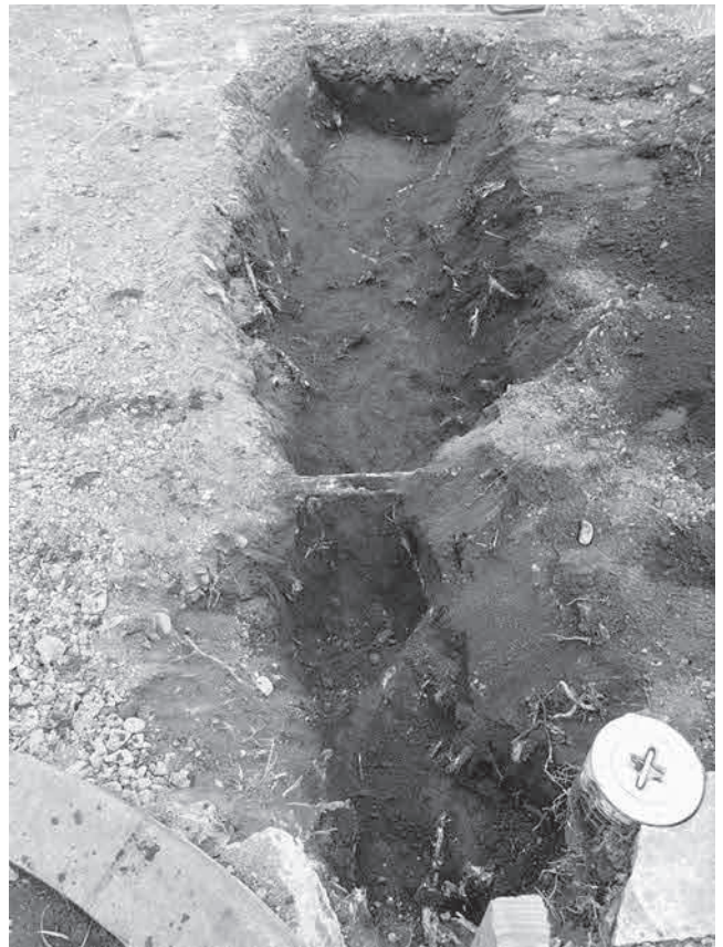
写真65 B 2 地点南側配線部掘削状況（東より）
