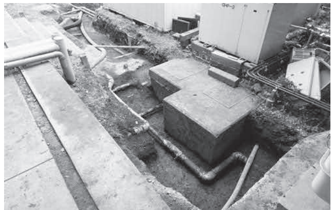
写真7 B5区東側掘削状況（東より）
