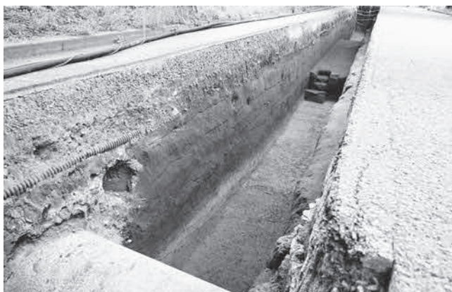
写真24 E3区掘削状況（北より）
