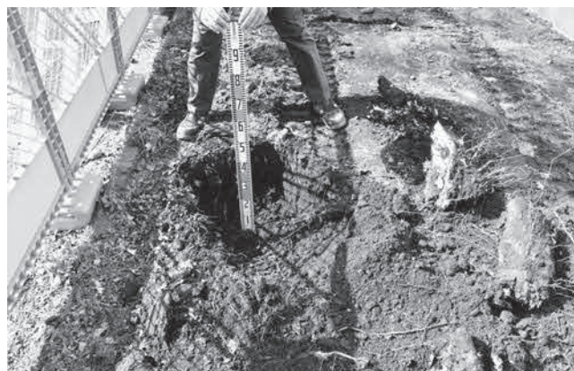
写真40 樹木3伐根完了状況 (東より)
