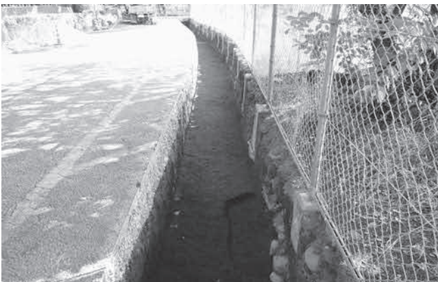
写真4 A1区南側掘削状況（北より）
