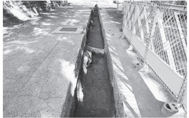
写真16 D2区掘削状況（西より）
