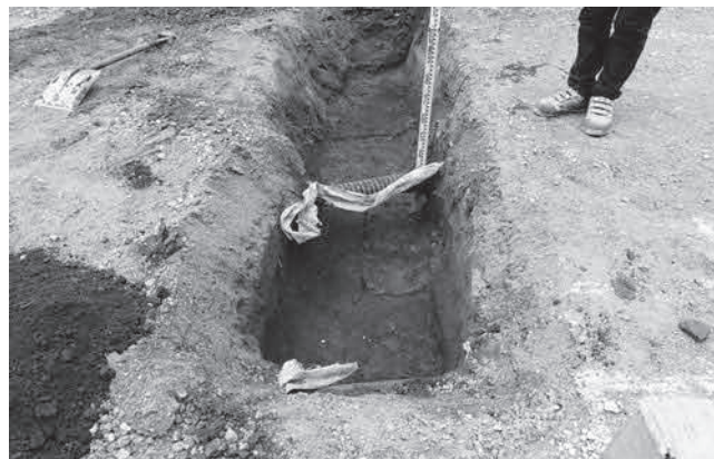
写真47 A 2 地点北側配線部掘削状況（東より）
