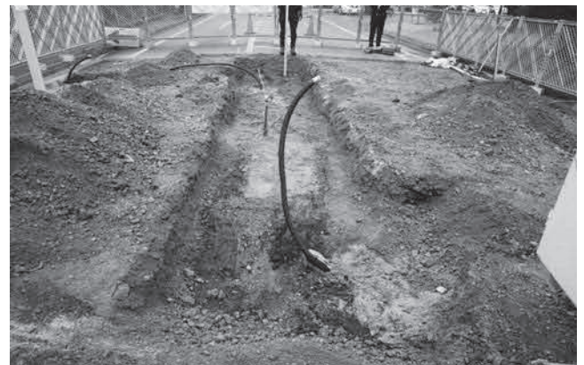
写真45 A1地点基礎部掘削状況 (南より)
