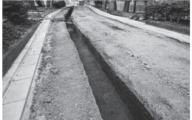
写真5 B6区北側掘削状況（南より）
