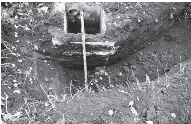
写真37 音楽棟南側中央部掘削完了状況 (南より)
