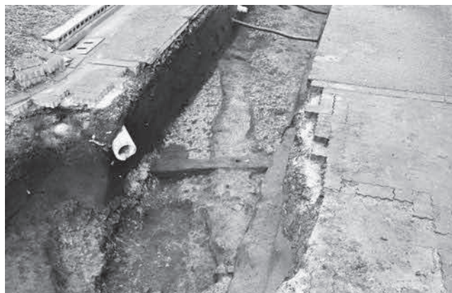
写真33 F 5区近世道路状遺構硬化面検出状況 (北より)
