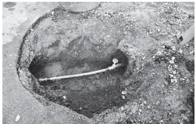
写真80 漏水管修繕完了状況(南より)
