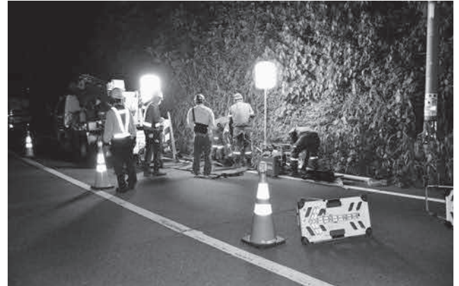
写真66 掘削作業風景（南東より）
