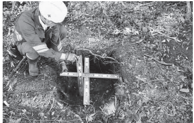
写真69 アンカー設置箇所の掘削完了状況
