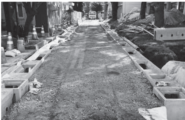
写真79 調査区近景(西より)
