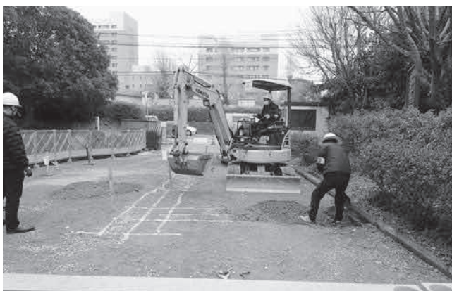
写真46 A 2 地点作業風景（北より）
