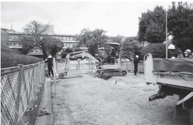
写真41 A1地点作業風景 (南より)
