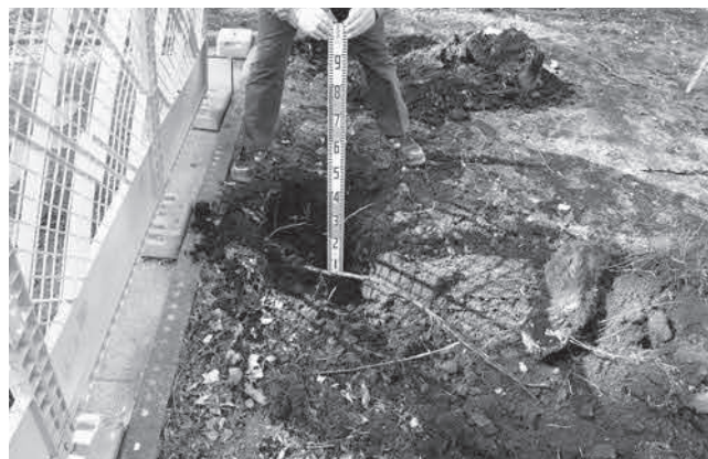
写真39 樹木2伐根完了状況 (東より)
