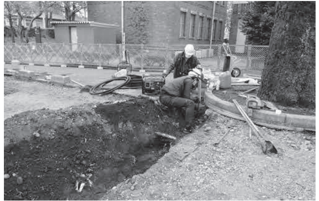
写真64 B 2 地点南側配線部作業風景（西より）
