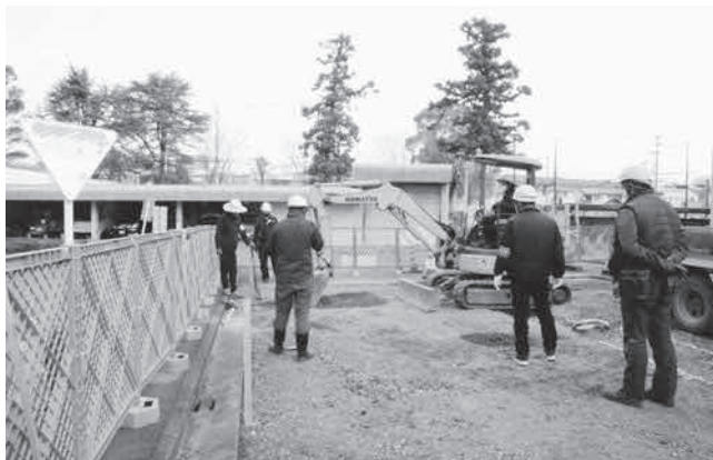
写真56 B1地点北側配線部作業風景(南より)
