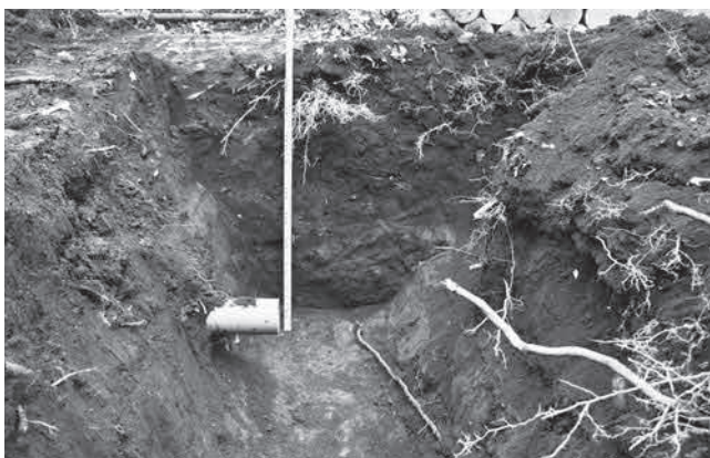
写真38 音楽棟北西側掘削完了状況 (東より)
