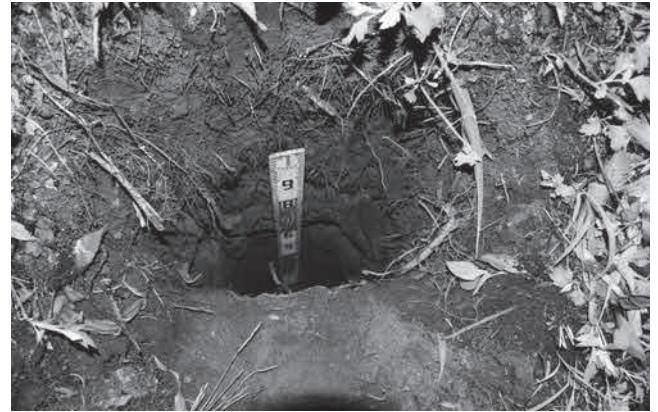
写真67 支線新設箇所の掘削状況（南より）
