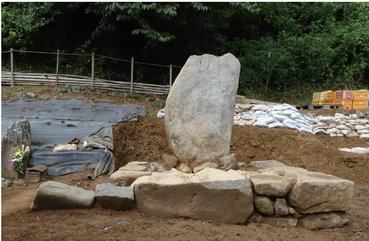
図 3-7 基壇検出状況（東から）
