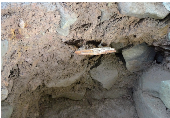
図3-53 西側竿通し金具 (I-11) (西から)
