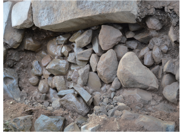
図 3-13 石組基壇 集石遺構上面
