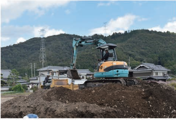
南半機械掘削
