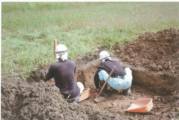
No.52 人力掘削
