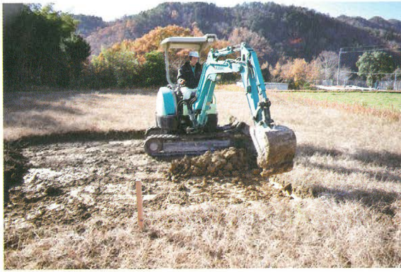
No.62 機械掘削
