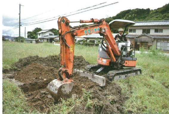
No.51 機械掘削
