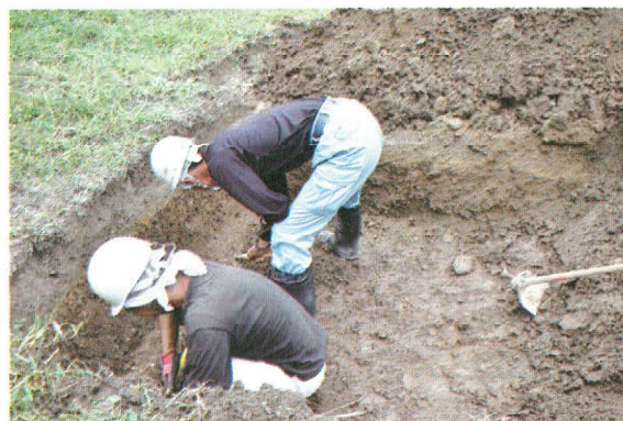
No.57 人力掘削
