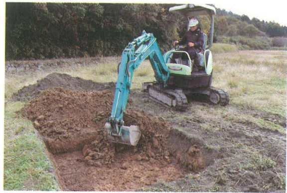
No.1 機械掘削
