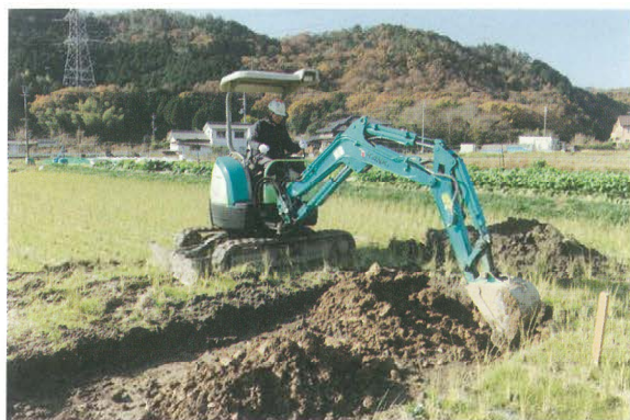
No.22 機械掘削
