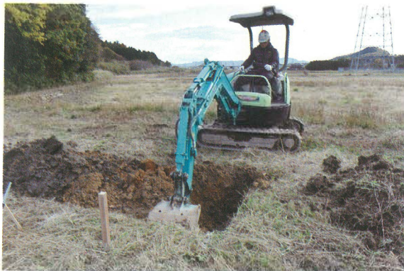
No.1-1 機械掘削
