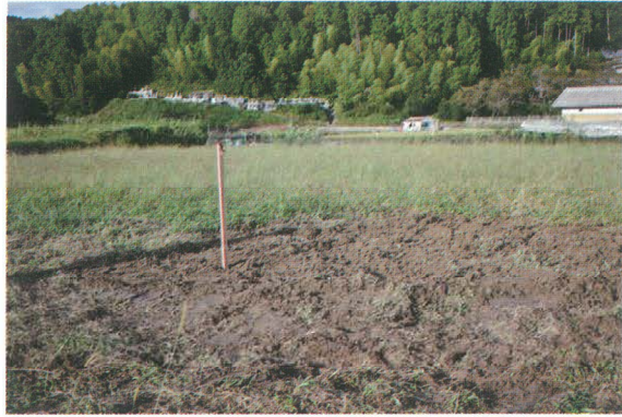
No.75 埋戻し終了 (南から)
