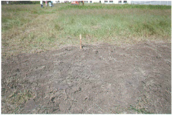
No.14 埋戻し終了 (南から)
