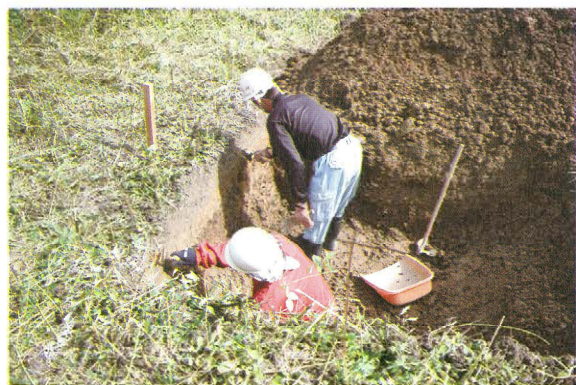
No.86 人力掘削
