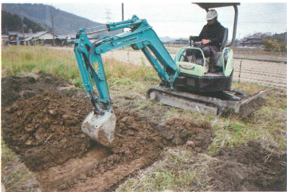
No.77 機械掘削
