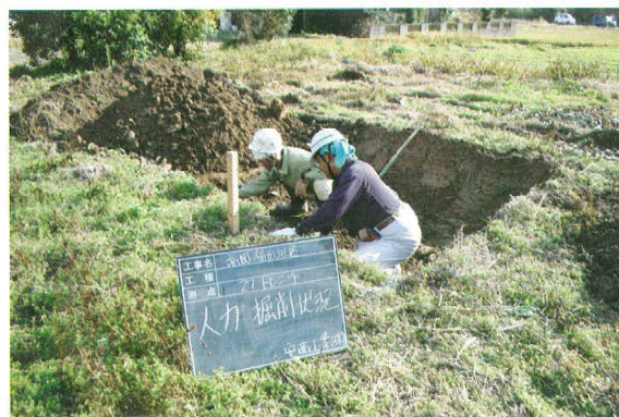
No.27 人力掘削
