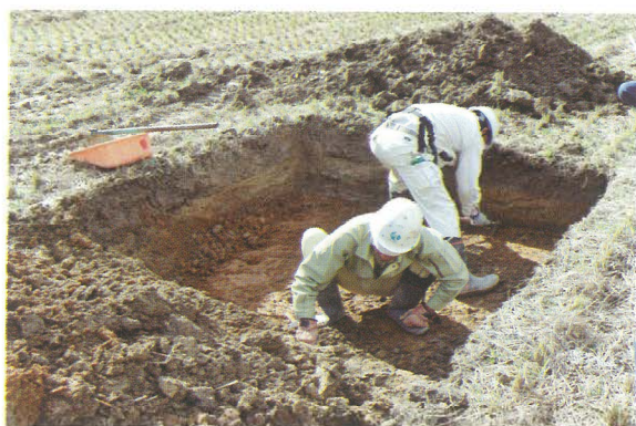
No.8 人力掘削
