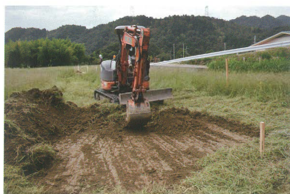
No.67 機械掘削
