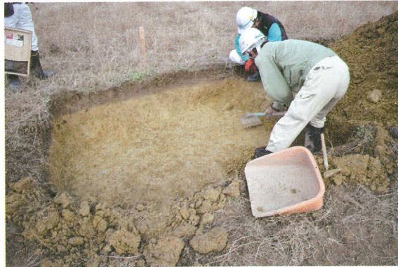
No.63 人力掘削
