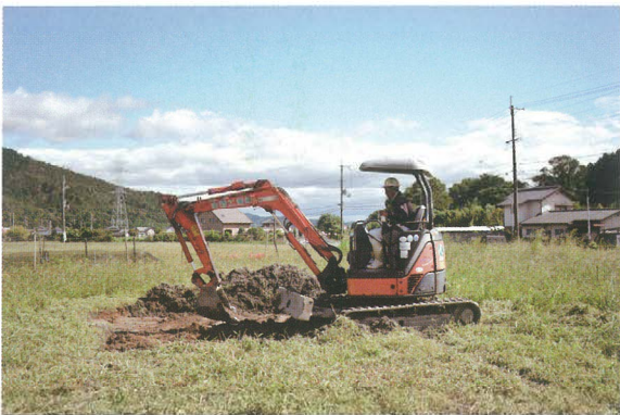
No.53 機械掘削
