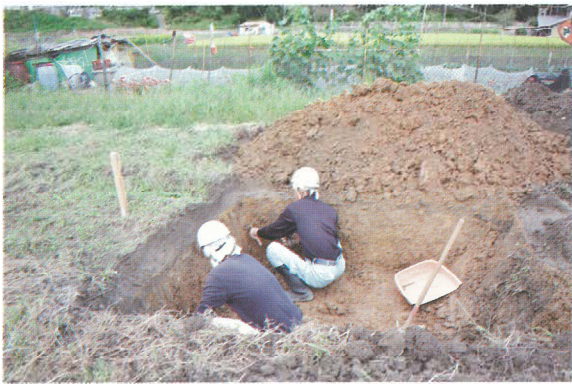
No.76 人力掘削
