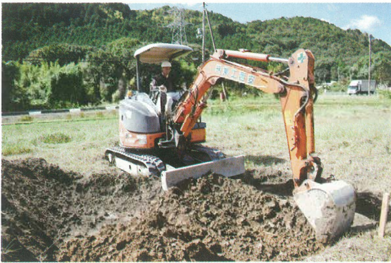
No.13 機械掘削
