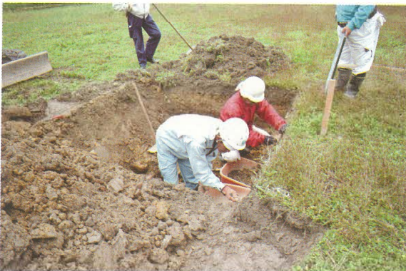
No.91 人力掘削
