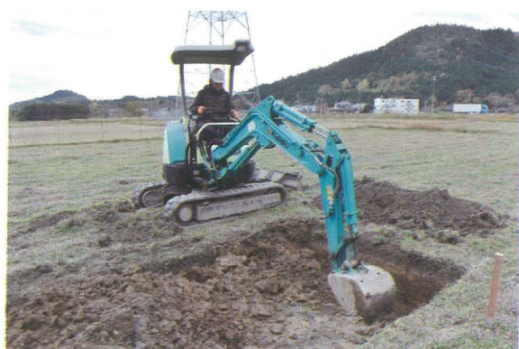
No.7 機械掘削
