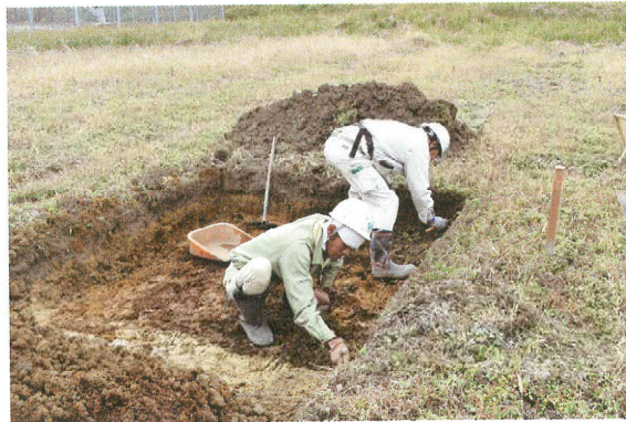
No.10 人力掘削
