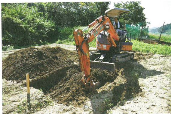
No.95 機械掘削
