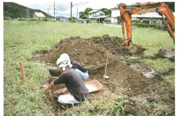
No.51 人力掘削
