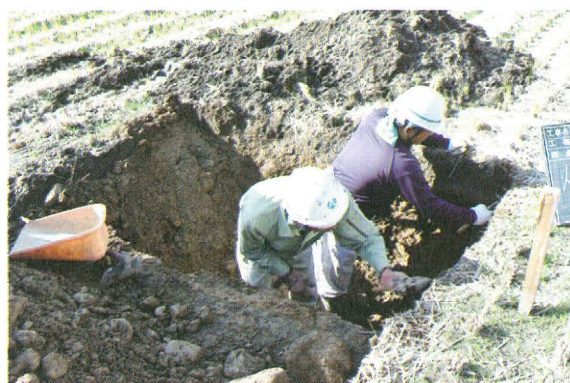
No.21 人力掘削
