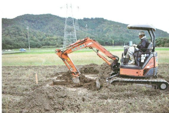
No.81 機械掘削
