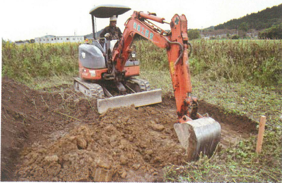
No.90 機械掘削
