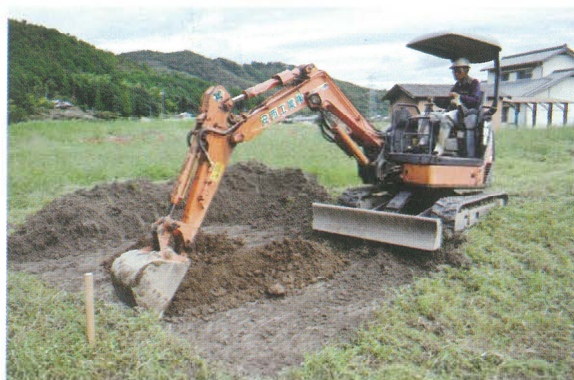
No.60 機械掘削
