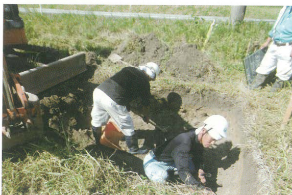
No.100 人力掘削
