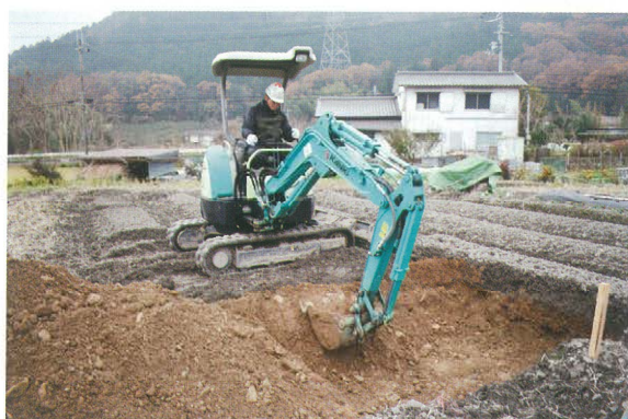
No.32 機械掘削
