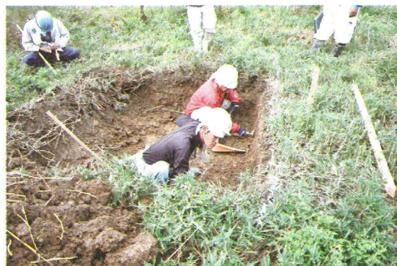
No.88 人力掘削
