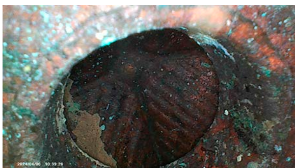
図16 笠裏側の空洞状態
