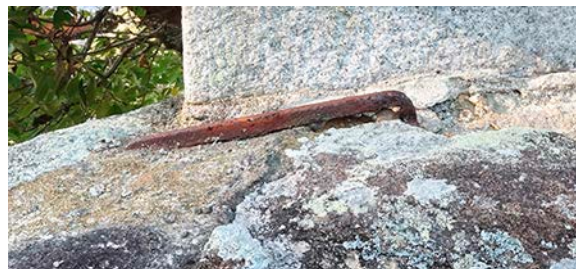
図3 鋸とモルタルによる部材の接合
