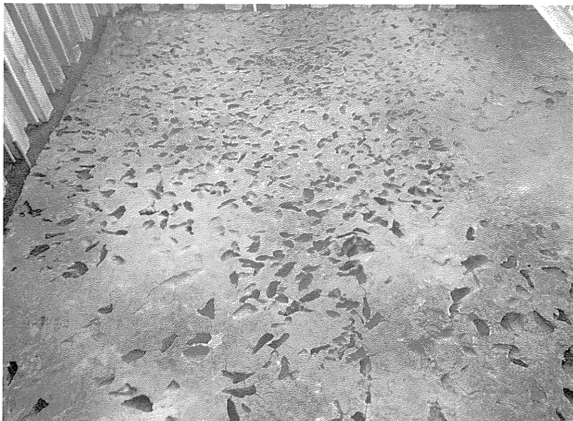
2Fトレンチ 足跡面 (東から)
