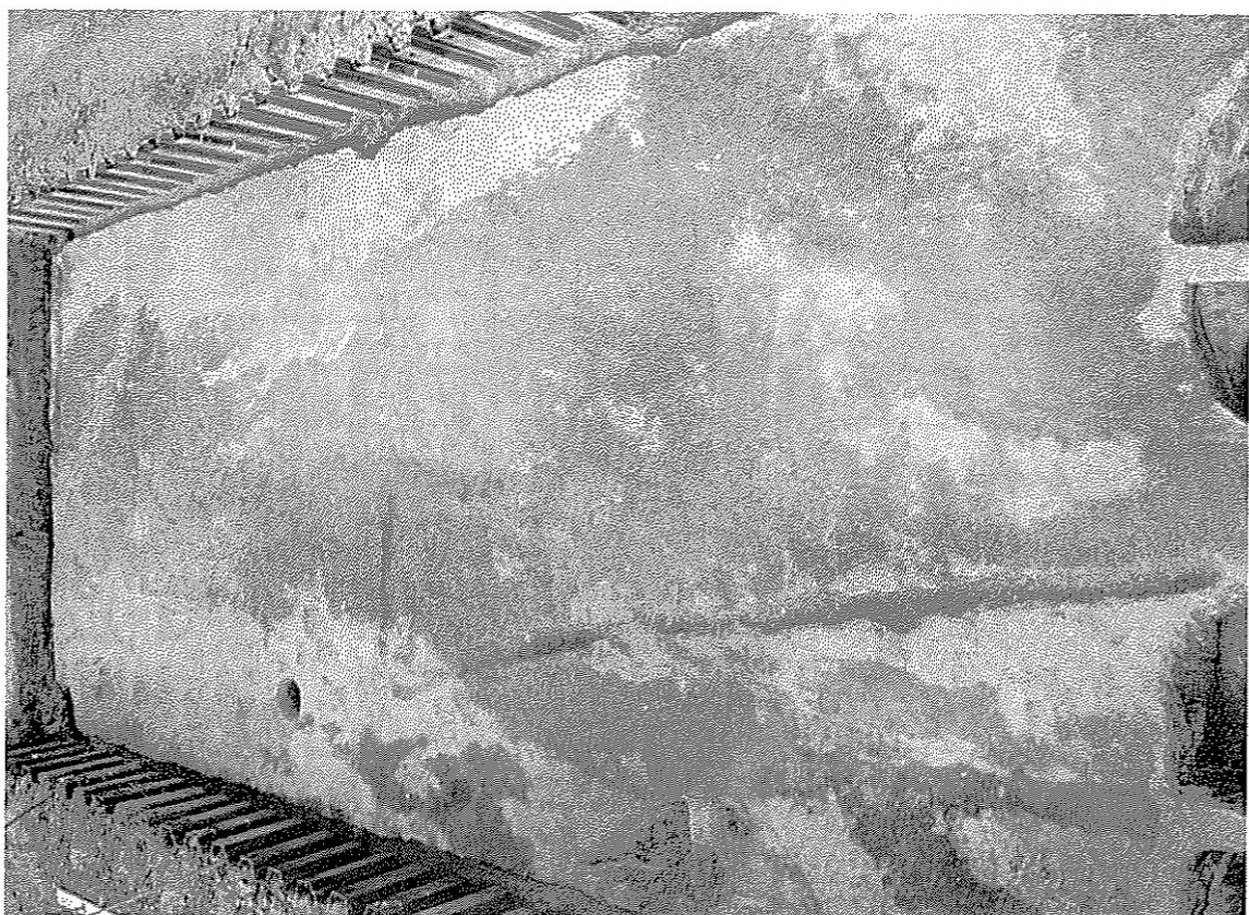
中世遺構面（南から）
