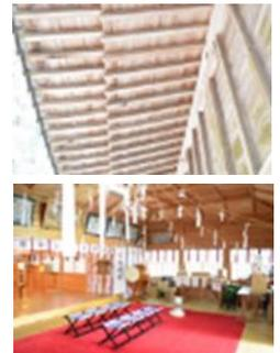
長享年間に修造、承応元年 (1652) および貞享3年 (1686) に本殿および拝殿を修復。明治38年 (1905) に拝殿および楼門を修復。昭和9年 (1934) 拝殿改築。平安時代に創建され、相良氏の入植後は藩主の崇敬深く、例祭当日には城主の御代参があったと伝わる。正面三間、奥行四間の入母屋造りで、規模が大きい。二軒疎垂木の軒は深い、組物は無く、ボルトで吊っている。
