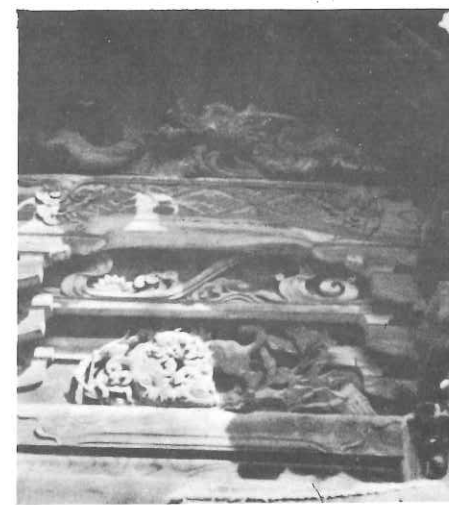
本殿西側彫刻
