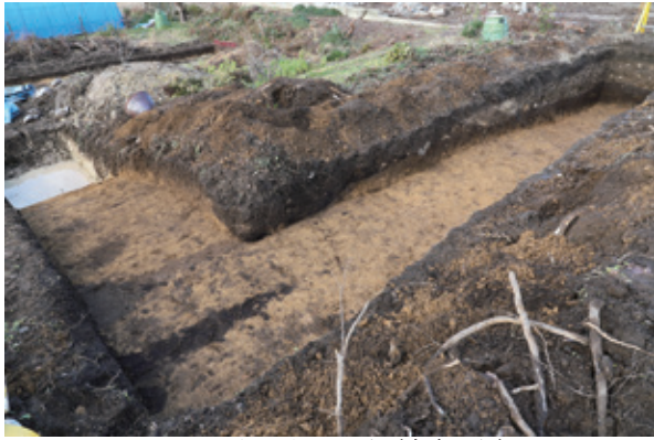
1. 5区T1トレンチ (南東から)
