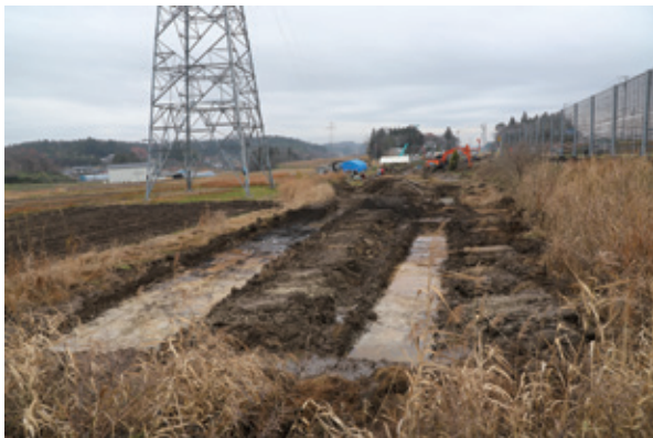
5. 5区T8・T10トレンチ (南から)
