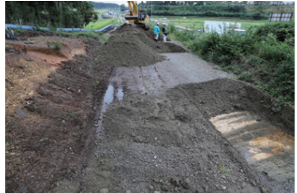
3. 仮設道路確認トレンチ（南西から）
