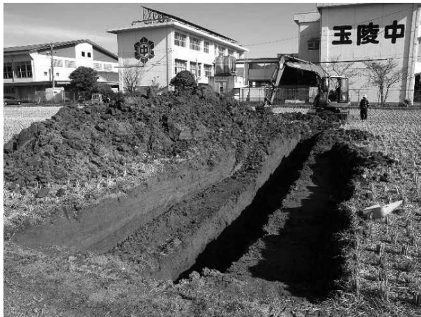
16 トレンチ調査状況 (西から)
