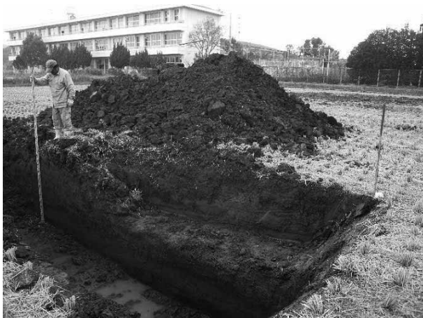
5トレンチ調査状況 (南東から)
