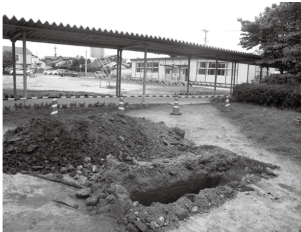
写真 28 古閑遺跡確認調査状況(南から)
