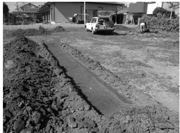
5トレンチ調査状況（西から）
