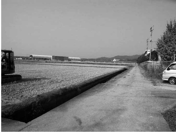
調査前状況 (東から)
