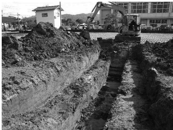
21 トレンチ調査状況 (西から)
