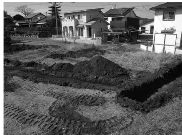
12 トレンチ付近調査状況 (東から)
