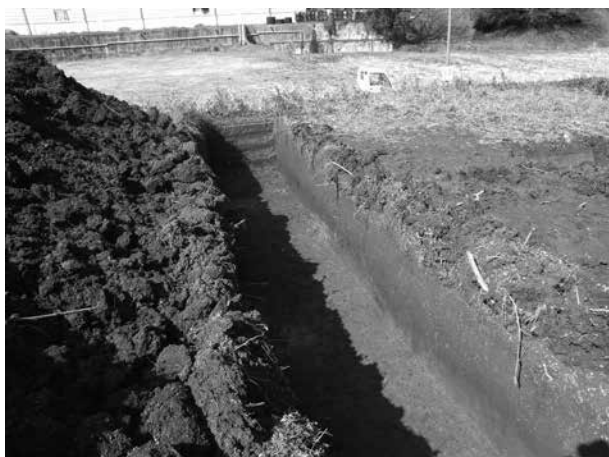
3 トレンチ調査状況（東から）
