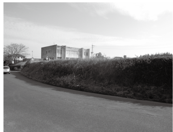
写真 22 東南大門遺跡 B 地点調査前状況 (南から)
