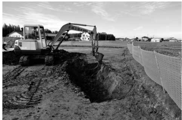
トレンチ掘削状況 (西から)
