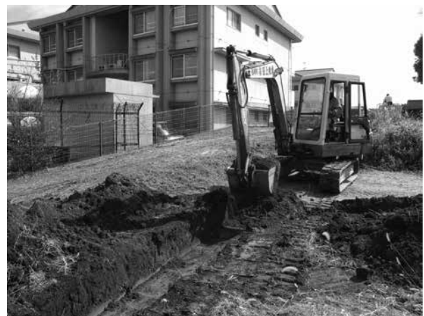
重機掘削状況 (北から)
