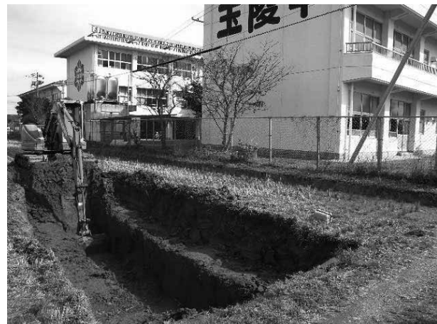
26 トレンチ調査状況 (南西から)
