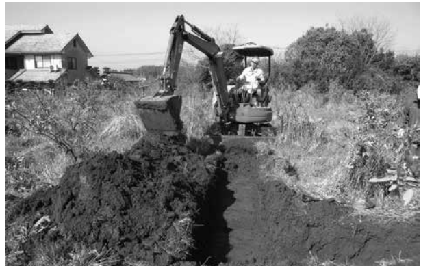
重機掘削状況 (南から)
