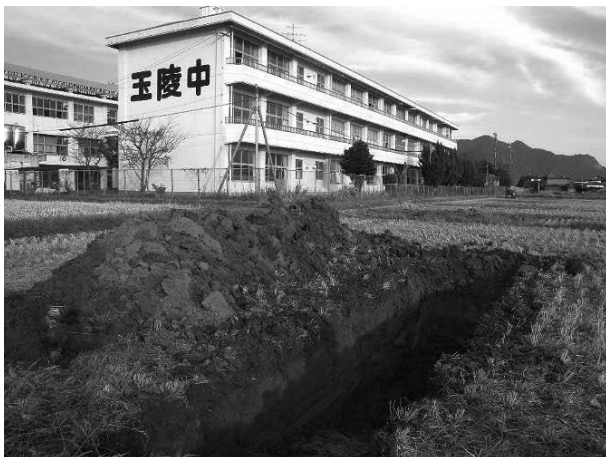
13トレンチ調査状況 (西から)
