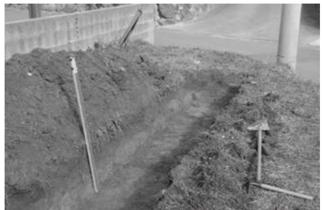
写真24 2トレンチ掘削状況 (南東から)
