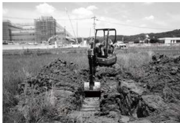
写真1 トレンチ掘削状況
