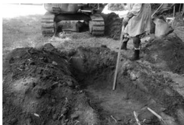
写真 10 来頭寺 1 トレンチ掘削状況 (東から)
