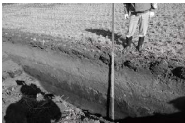
写真 16 玉名平野遺跡群 (B -2 地点) 1461T 調査状況
