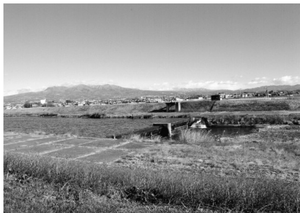
写真1 八坂用水の頭首工 （前橋市筑井町 桃ノ木川右岸から）
