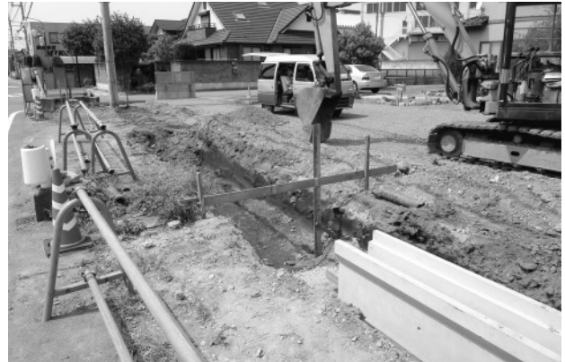
写真21 六供町の道路工事現場
