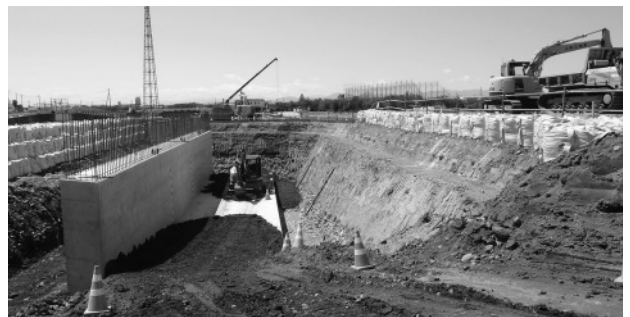
写真12 上武道路と交差する細ヶ沢川右岸護岸断面
