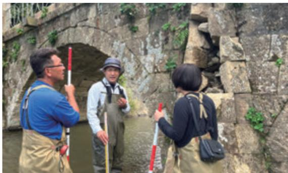
(図55) 被災した「めがね橋」の外観調査
