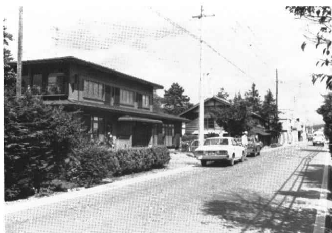
鹿角街道寺田駅所跡付近 (西根町寺田地内)
