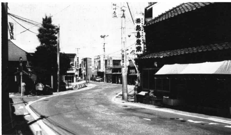
四ツ家御門・斜形跡付近 (盛岡市本町通 丁目地内)
