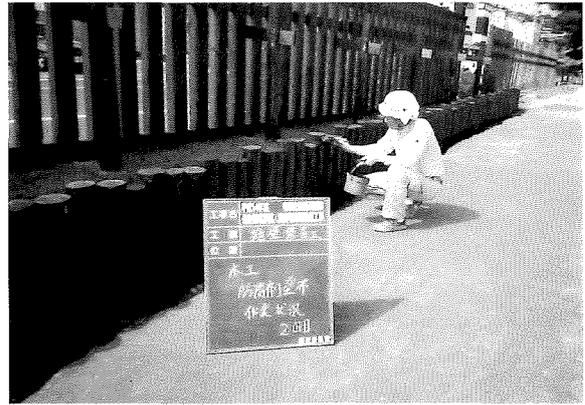
2 擁壁前土留丸太 防腐剤塗布(東より)
