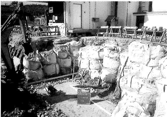
5 土留L型擁壁 土のう設置 (東より)
