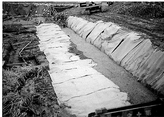
2 護岸石垣 基礎工・養生工（北より）
