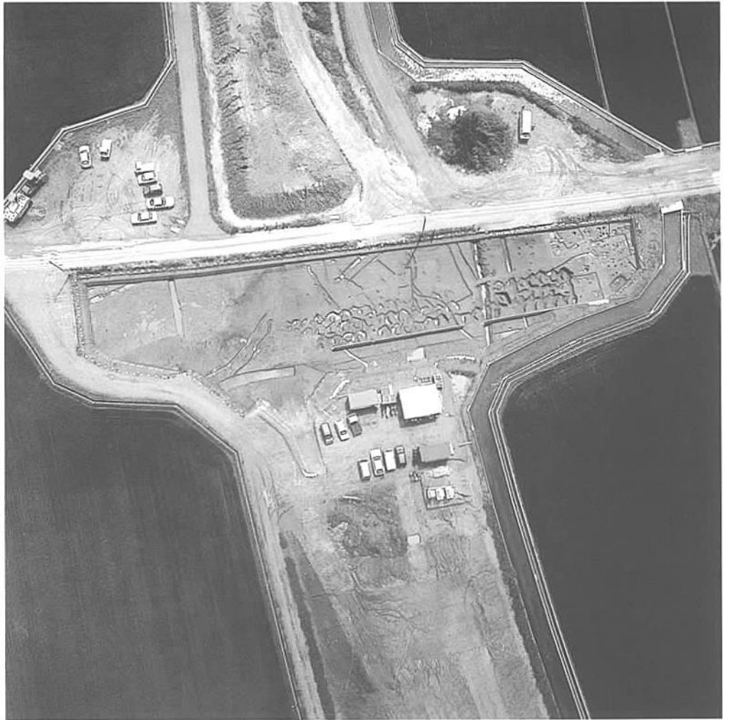
1 I区東端部全景 (空中写真)
