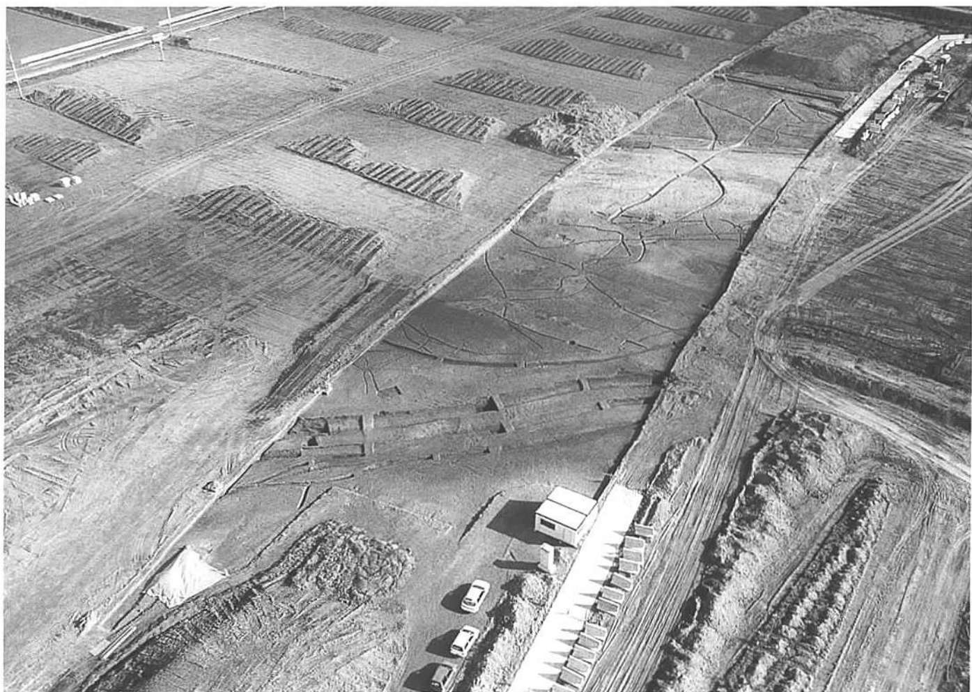
2 II区全景(空中写真)
