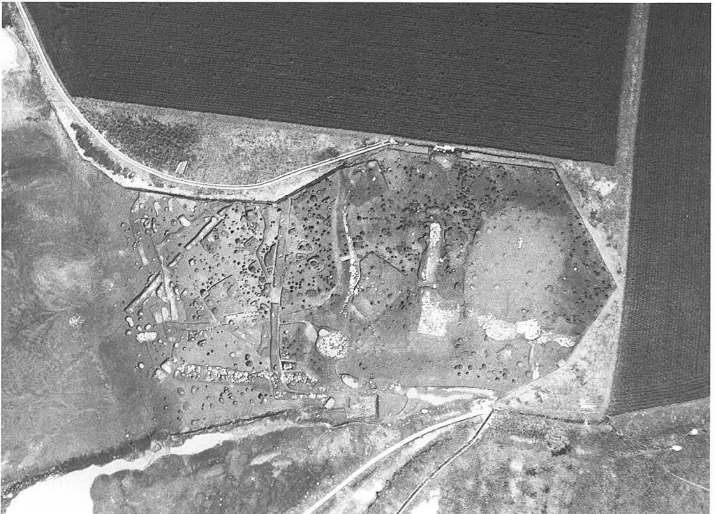
2. 北東部全景（空中写真 上から）
