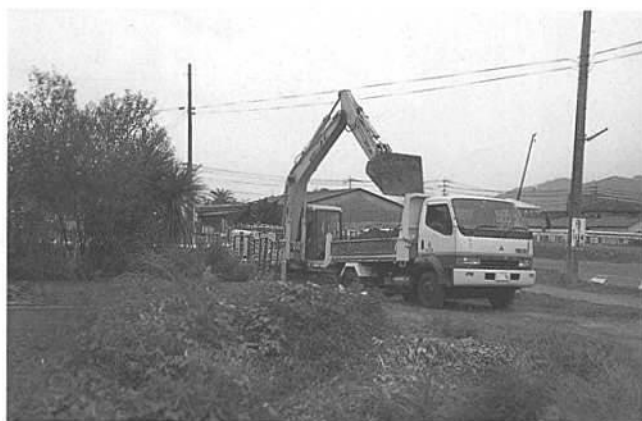
5区トレンチ掘削状況
