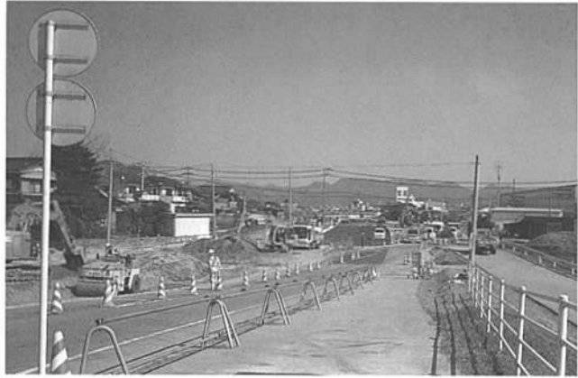
堂畑遺跡調査後工事状況
