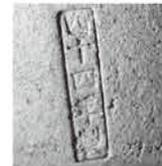
写真50b 長方形枠内に「四十四年製」押印
