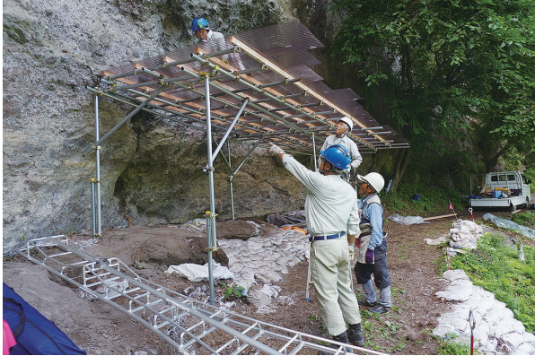
岩陰部 屋根の取り付け (第4次調査)
