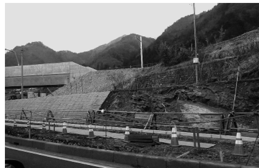
写真8 周辺工事の露頭(2015年9月) ここでは天明泥流堆積物は確認できない。
