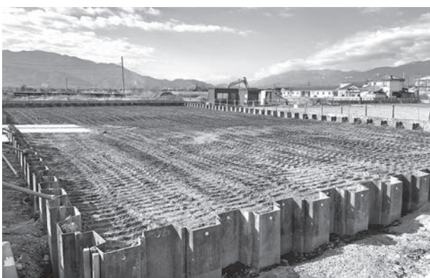
A区 埋め戻し完了状況
