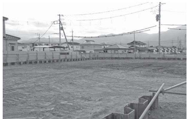
A・B区 埋め戻し完了状況
