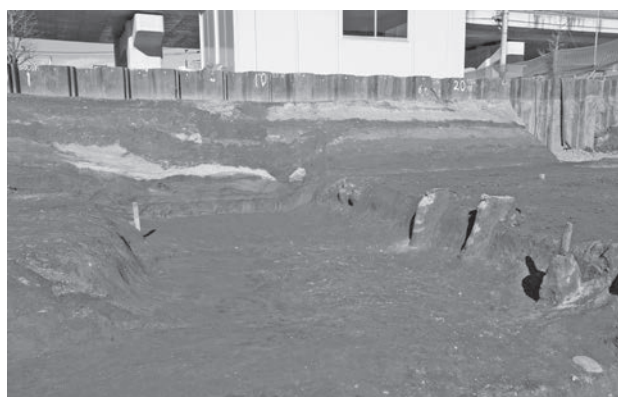
SD1 木杭検出状況(北側)
