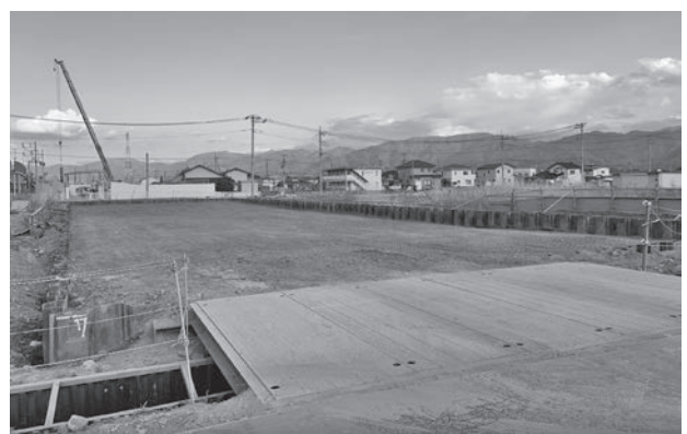
B区 埋め戻し完了状況
