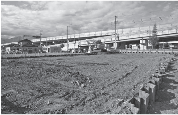
A区 着手前状況
