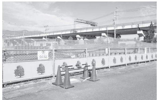
調査区養生状況
