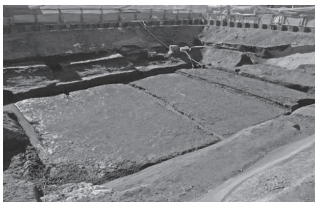
調査区完掘状況
