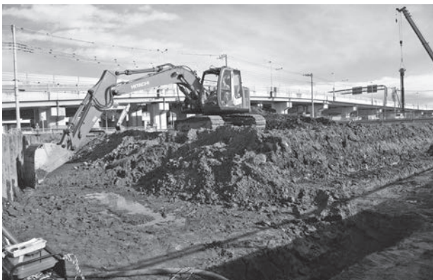
A区 表土はぎ状況
