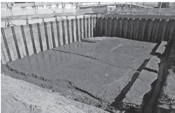
調査区完掘状況
