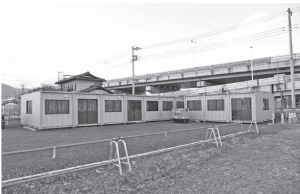
プレハブ設置状況
