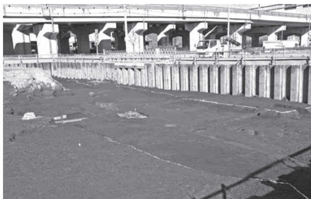
SD1 完掘状況
