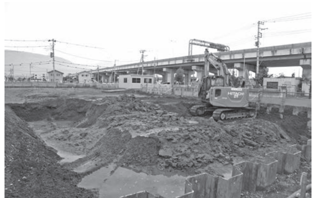
A区 表土はぎ状況
