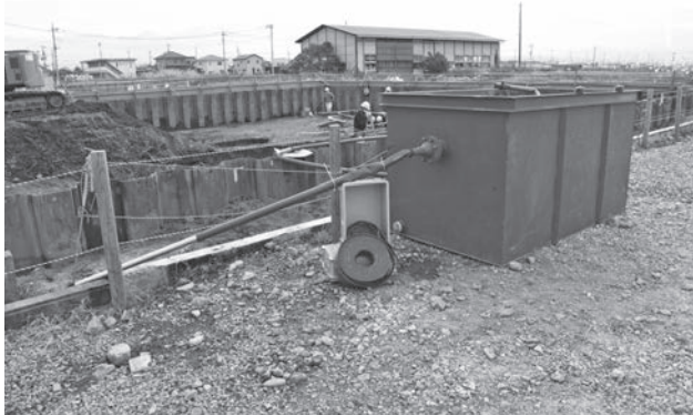
ろ過タンクを用いて排水している様子（第5次調査）
