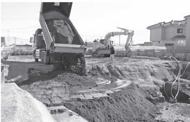
A区 埋め戻し状況
