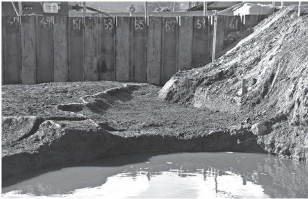
SD2 完掘状況
