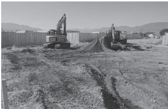
重機による表土掘削作業
