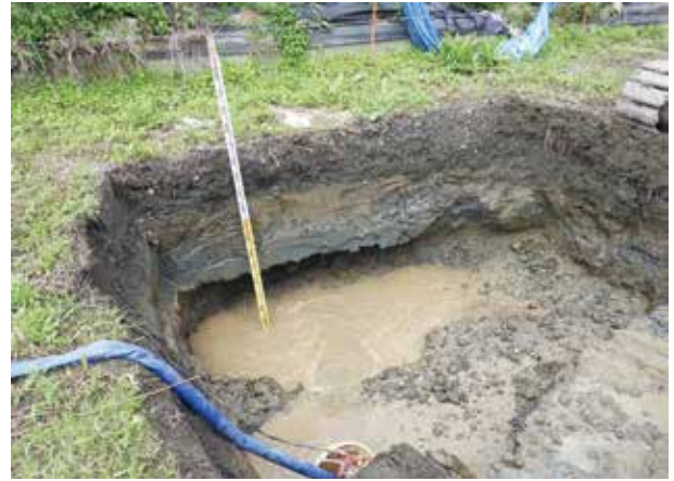
No.2-南-1 トレンチ全景
