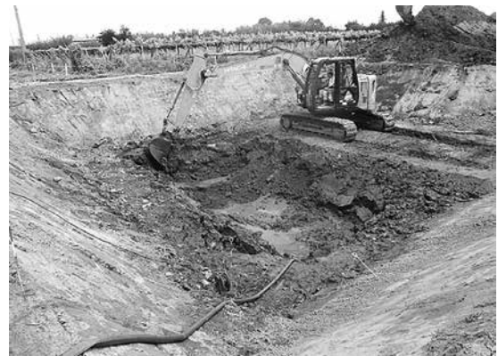
新2地点トレンチ完掘状況
