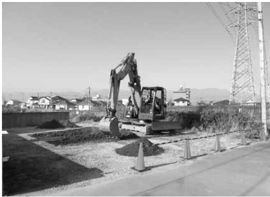
新4c 地点掘削状況
