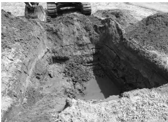
新1 a地点トレンチ完掘状況
