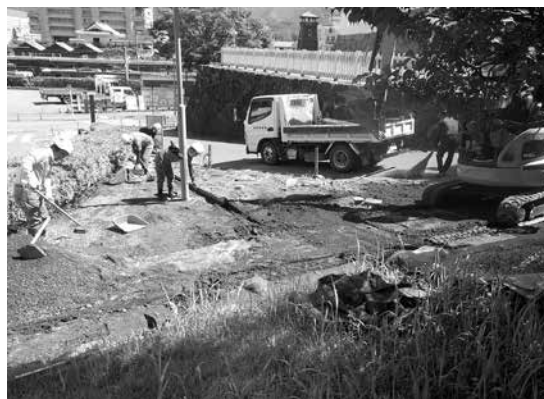
土壌のすき取り作業状況
