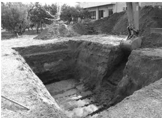
新4a地点トレンチ完掘状況
