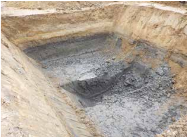
No.4 新5地点トレンチ完掘状況
