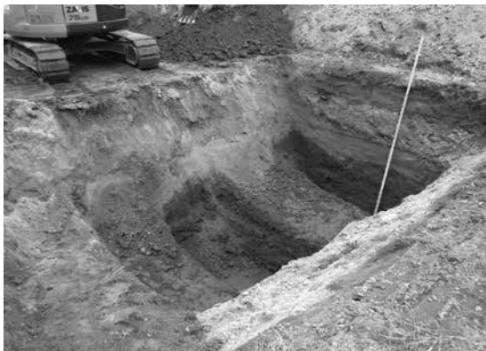
新3地点トレンチ完掘状況
