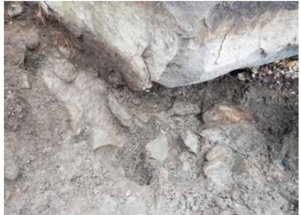
No.1 岩盤検出状況
